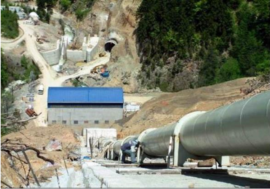
Şekil 1.12. Depolamasız HES İnşaatı
