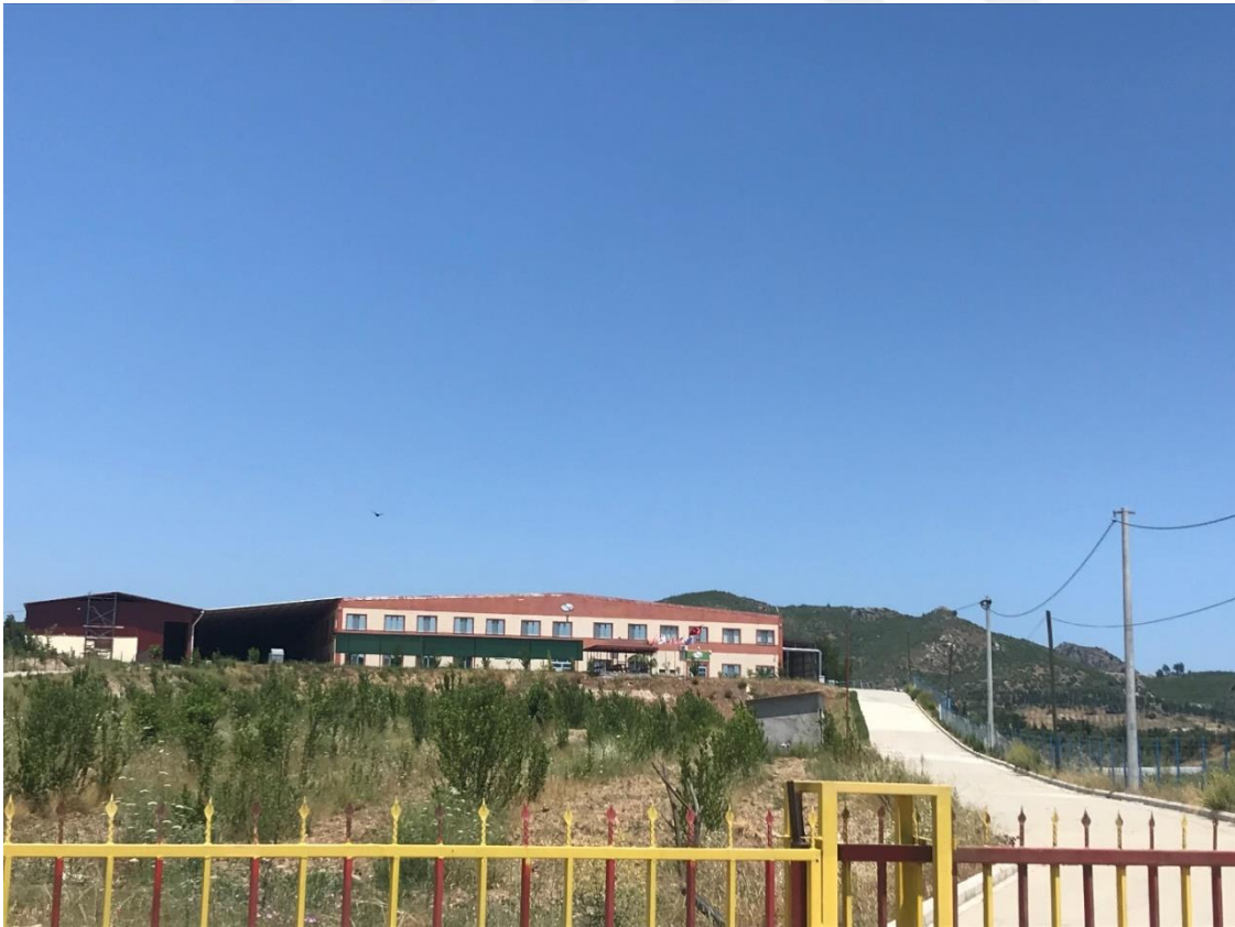
Fotoğraf 2.7 Deniztepesi Mahallesi Kekik Yağı Fabrikası
