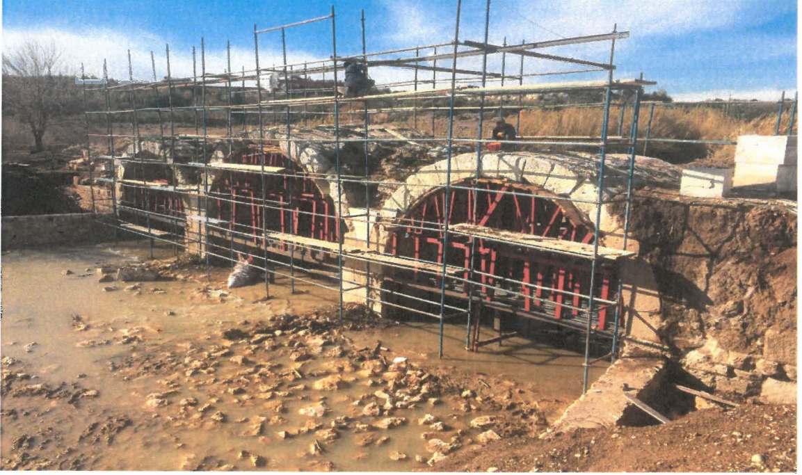
Şekil 4.9. Ayvalıkemer (Sillyon) köprüsü mansap yönü restorasyon uygulaması
