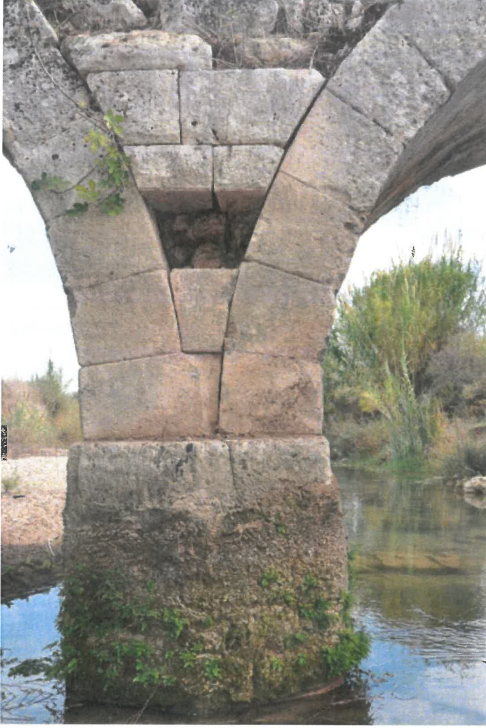
Şekil 4.7. Ayvalıkemer (Sillyon) köprüsü tempan duvarı ve sel yaran
