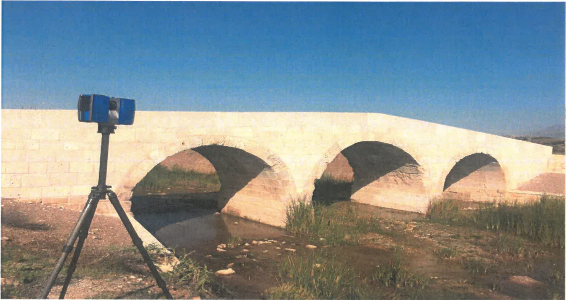
Şekil 3.32. Yapının yenileme çalışmaları sonrası tarama yapan istasyonlardan birisi
