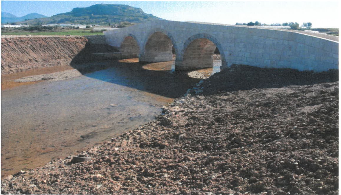
Şekil 4.10. Ayvalıkemer (Sillyon) köprüsü memba yönü restorasyon uygulaması
