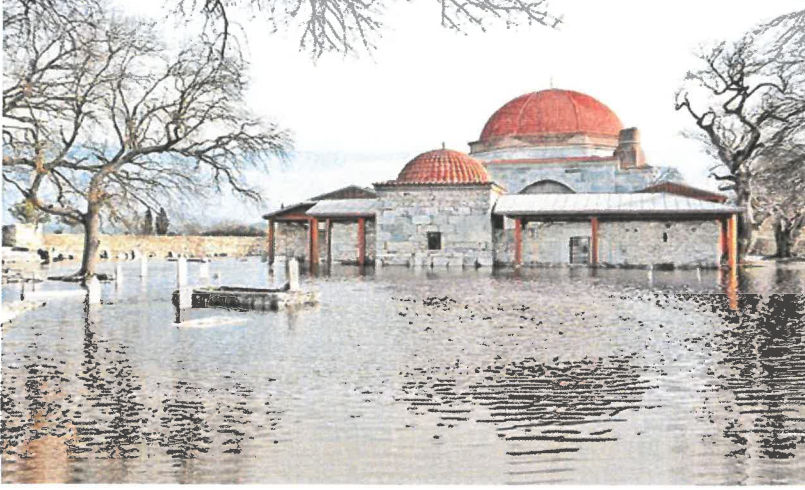
Şekil 3.29. Tarihi bir yapıda sel baskını sonucu oluşan tahribat
