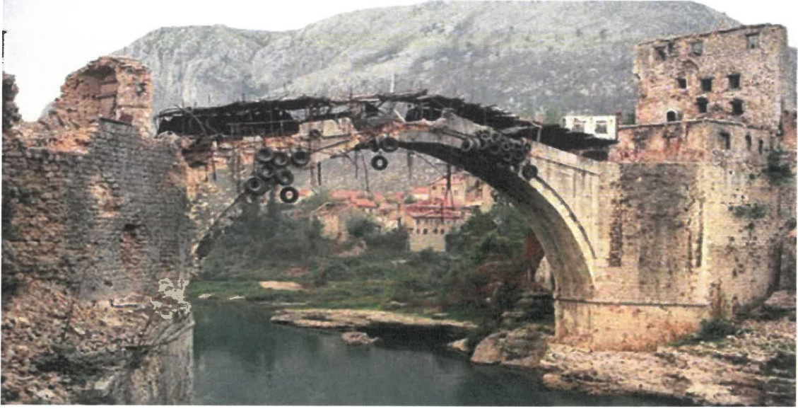
Şekil 3.30. Savaş nedeni ile hasar gören tarihi Mostar köprüsü (Anonim 16, 2019)
