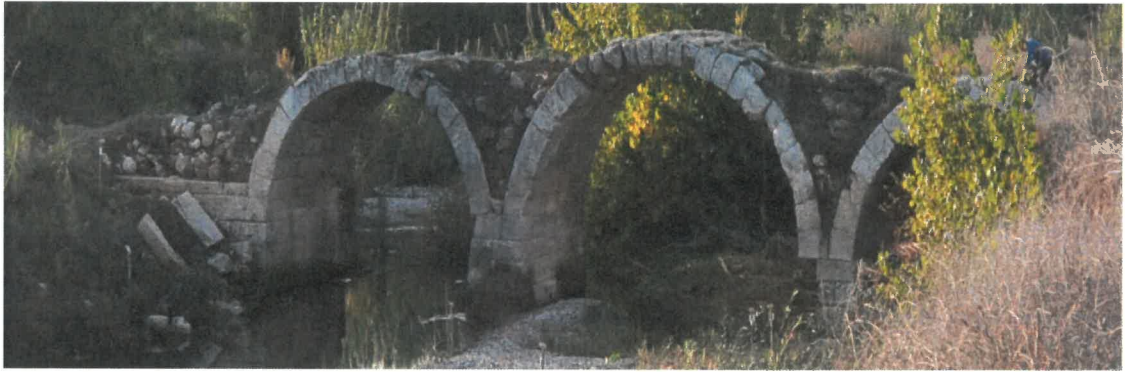
Şekil 4.6. Ayvalıkemer (Sillyon) köprüsü mansap cephesi
