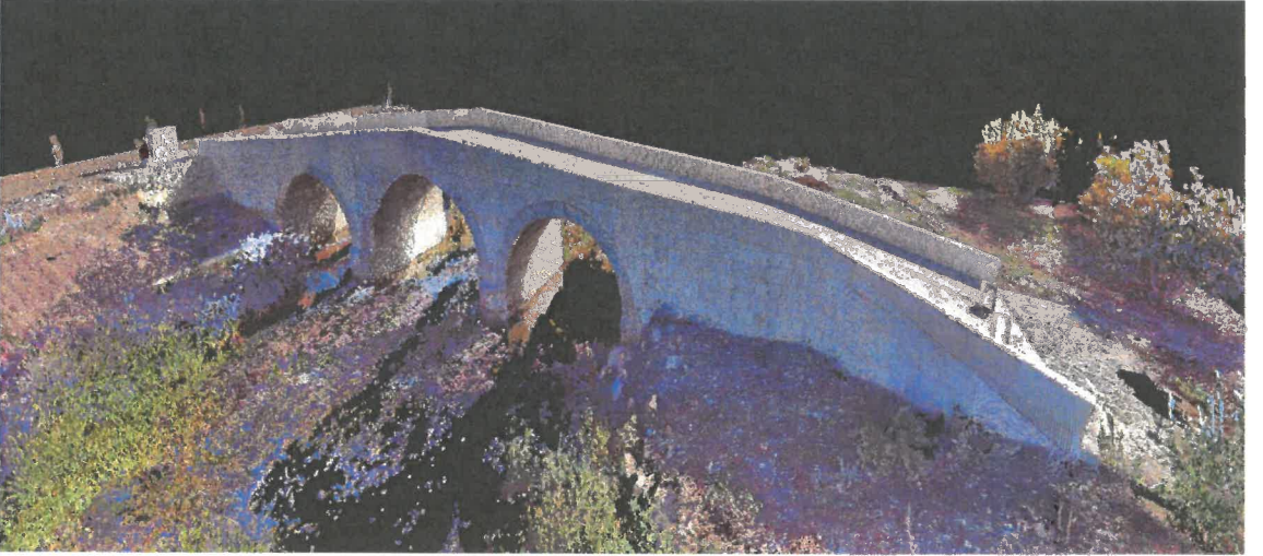
Şekil 4.12. Köprü restorasyon sonrası yersel lazer tarama yoluyla edinilen memba yönü nokta bulutu dosyası
