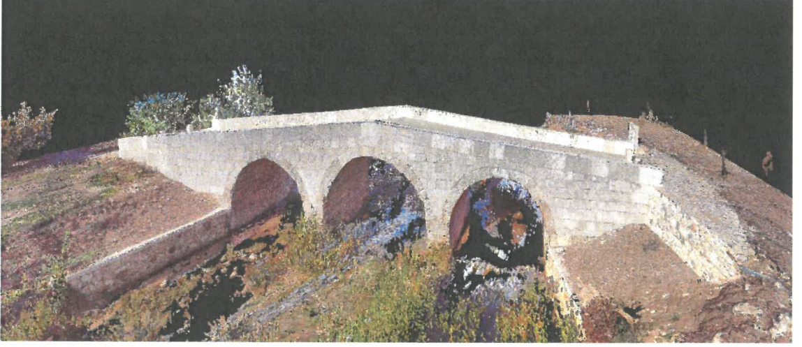
Şekil 4.11. Köprü restorasyon sonrası yersel lazer tarama yoluyla edinilen mansap yönü nokta bulutu dosyası
