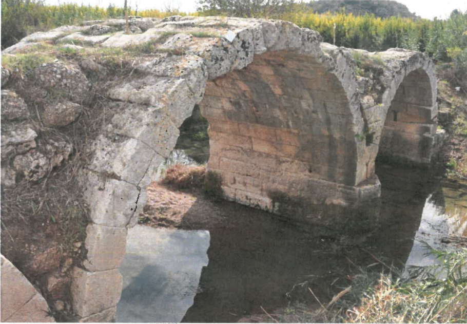
Şekil 4.1. Ayvalıkemer (Sillyon) köprüsü memba yönü
