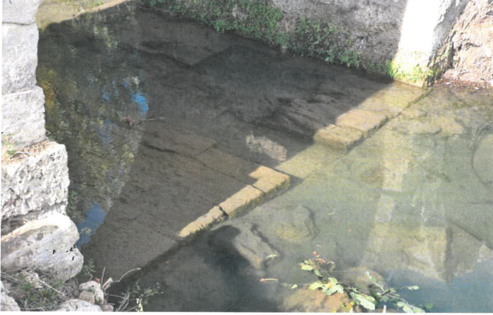
Şekil 4.2. Ayvalıkemer (Silyon) köprüsü temel yapısı
