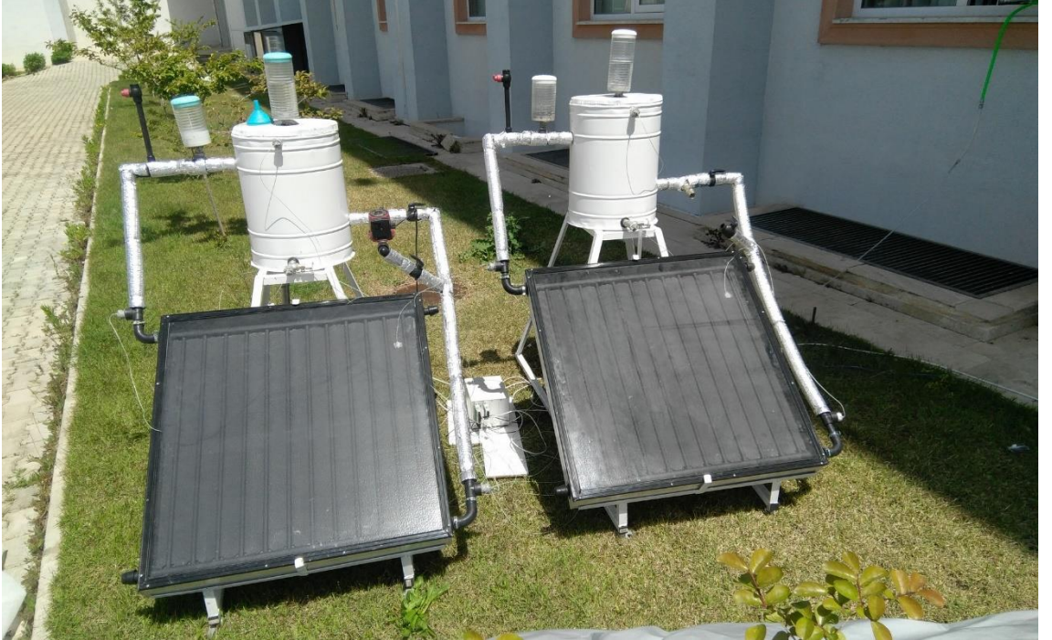
Şekil 3.22. Montajı tamamlanmış iki sistemin çeşitli açılardan deney anındaki görüntüsü
