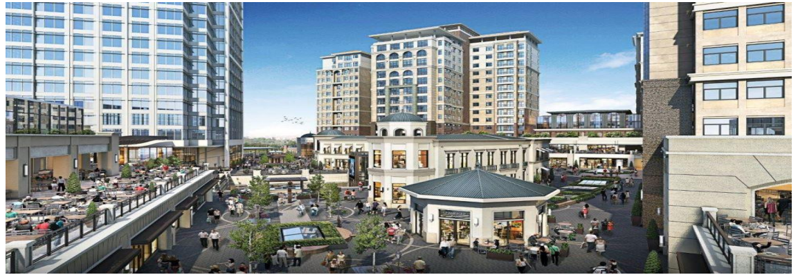
Şekil 2.7. EMAAR Square alışveriş merkezi binası (Entegre Proje Yönetim 2016)
