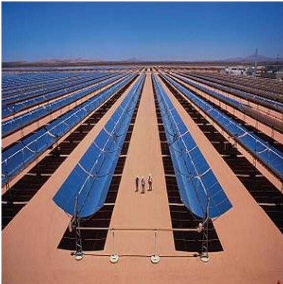
Şekil 2.9 Parabolik Oluk Kolektörlü Enerji Santrali
