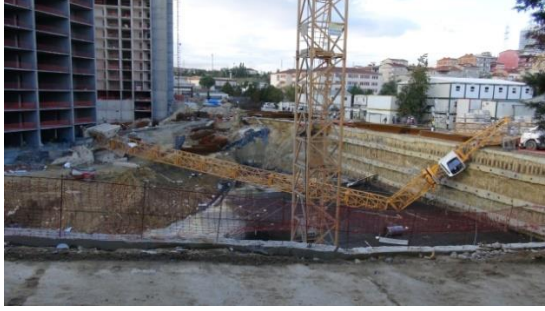
Şekil 2.36. 2014 yılında, İstanbul’da şiddetli fırtınada devrilen kule vinç ve 2016 yılında, İzmir’de okulun çatısına devrilen kule vinç
