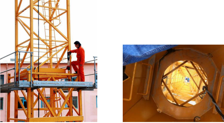
Şekil 2.13. Mast kafes sistemi cıvata montajı ve operatör tırmanma merdiveni (Çayıroğlu)
