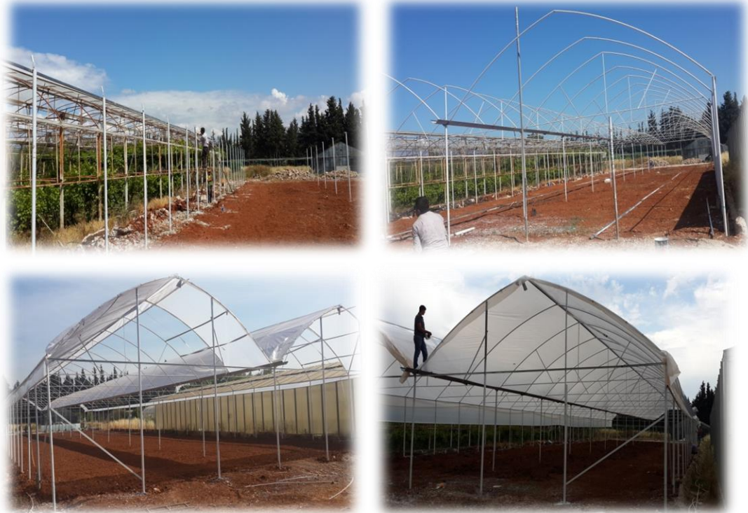
Şekil 3.1. Deneme alanına üstü kapatılıp açılabilen sera benzeri yapının inşası aşamaları
