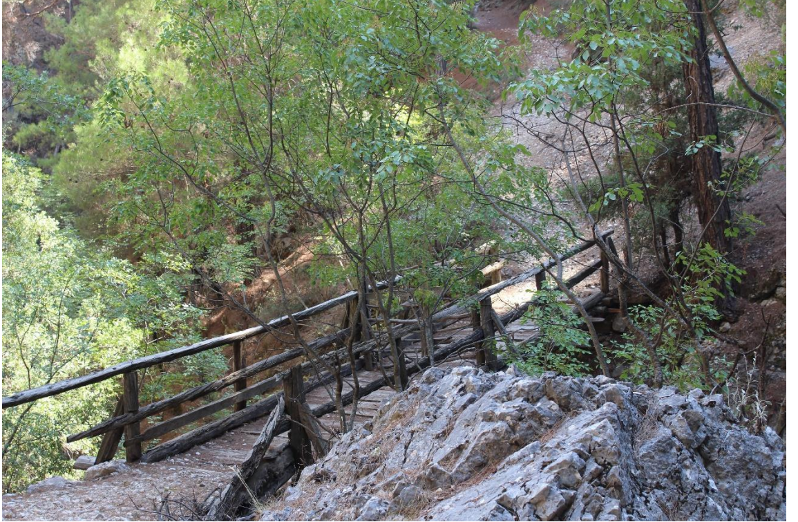
Şekil 1.10. Vadi tabanındaki köprü
