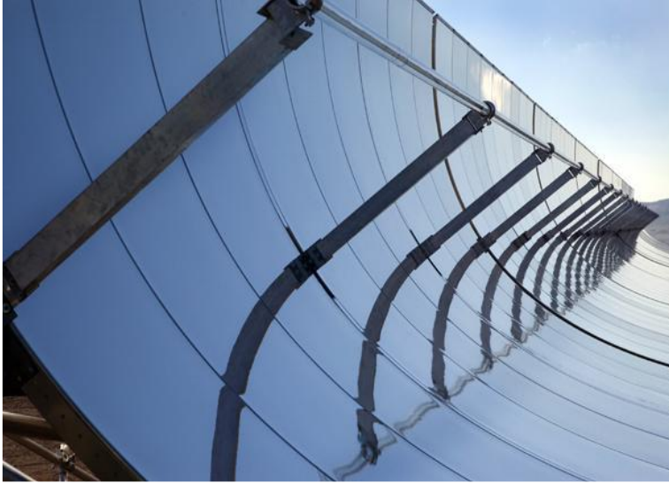
Fotoğraf 2.1 Parabolik Aynalı Kolektör
