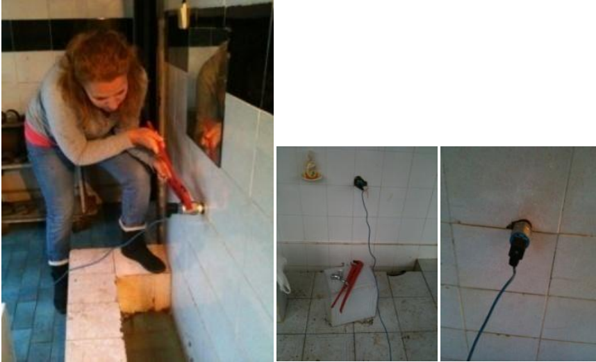
(a) Sahada manuel basınç ölçümü için basınçmetrenin takılması
