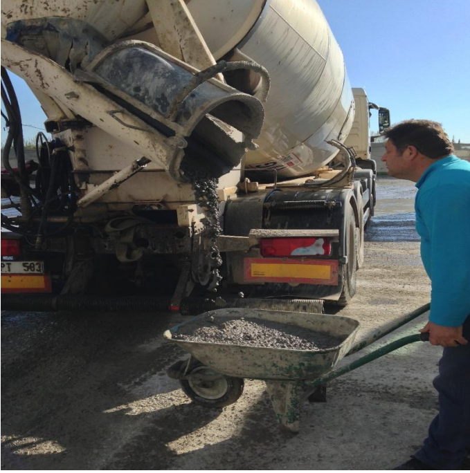
Şekil 4.2. Transmikserden numune alınması
