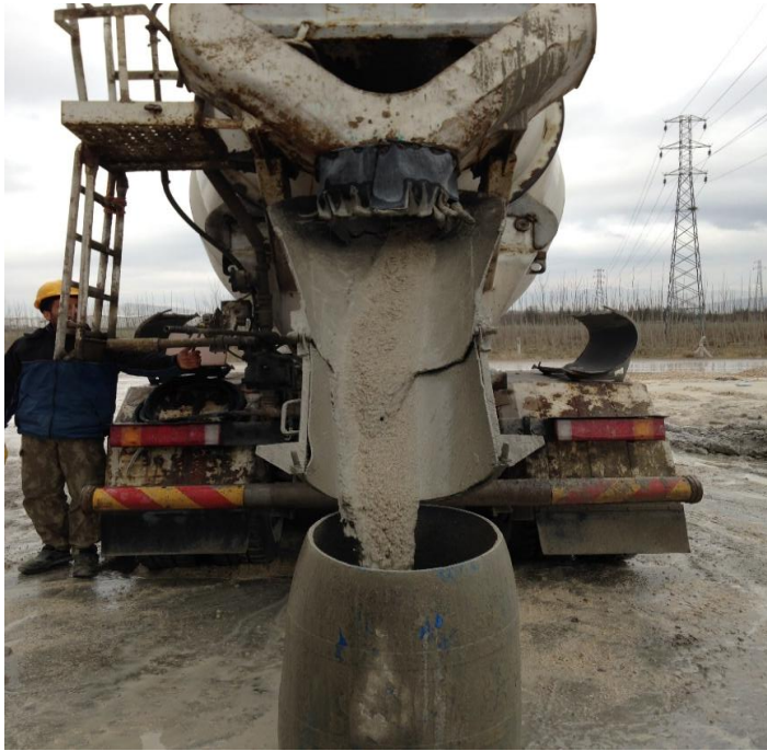
Şekil 4.4. Transmikserin çeperlerine yapışan atık beton
