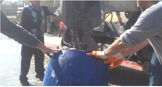
Şekil 3.1. Atık betonun transmikslerden alınması
