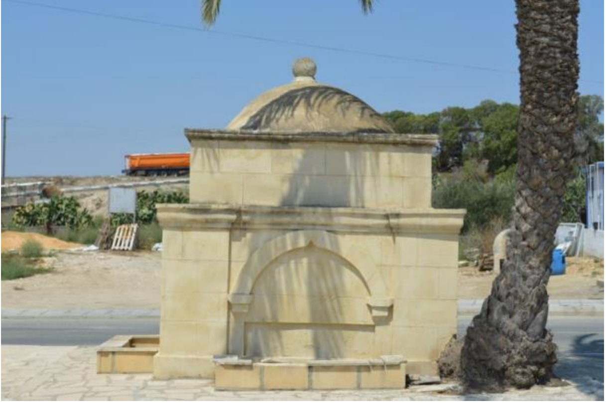
Foto 3.93 Celya Köyü Cami Çeşmesi, Doğu Cephe
