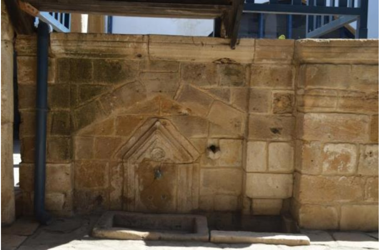
Foto.3.28 Lefkoşa, Derviş Paşa Konağı Çeşmesi, Güney Cephe
