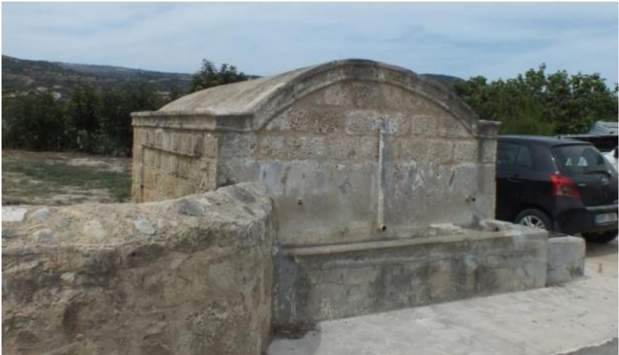
Foto 3.7Hirsofu Köyü Çeşmesi, Doğu Cephe
