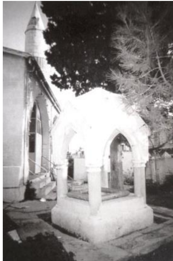
Foto 2.23 Çeşmenin Taşındıktan Sonraki Durumu 229
