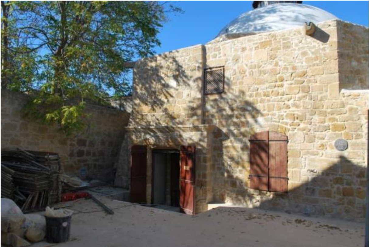
Foto 3.96 Lefkoşa, Ömerge Hamamı, Soyunmalığın Güney Cephedeki Girişi
