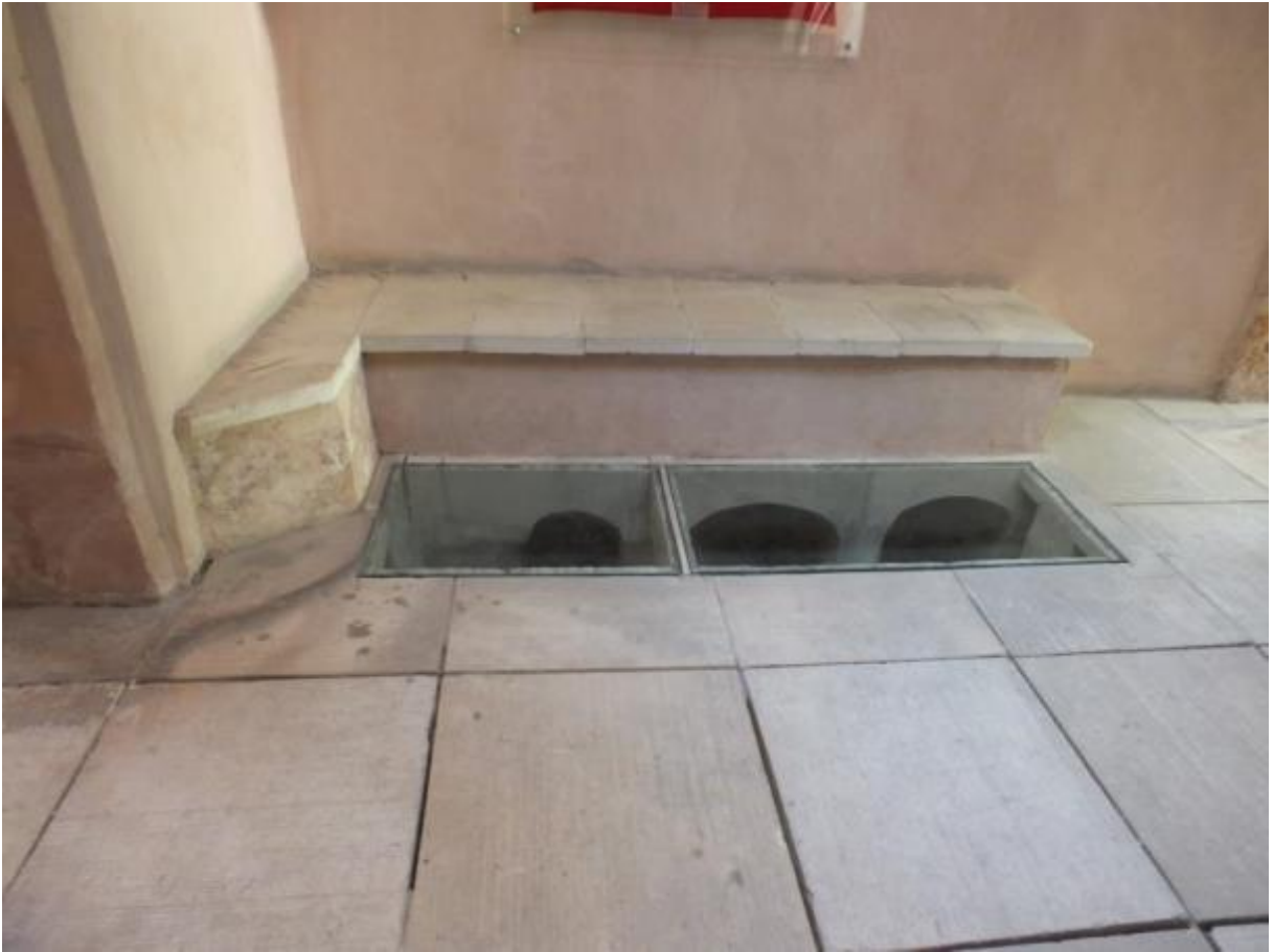
Foto 3.112 Kuzeydeki Soğukluk Bölümünde Yer Alan Seki ve Altındaki Cehennemlik Kanalları
