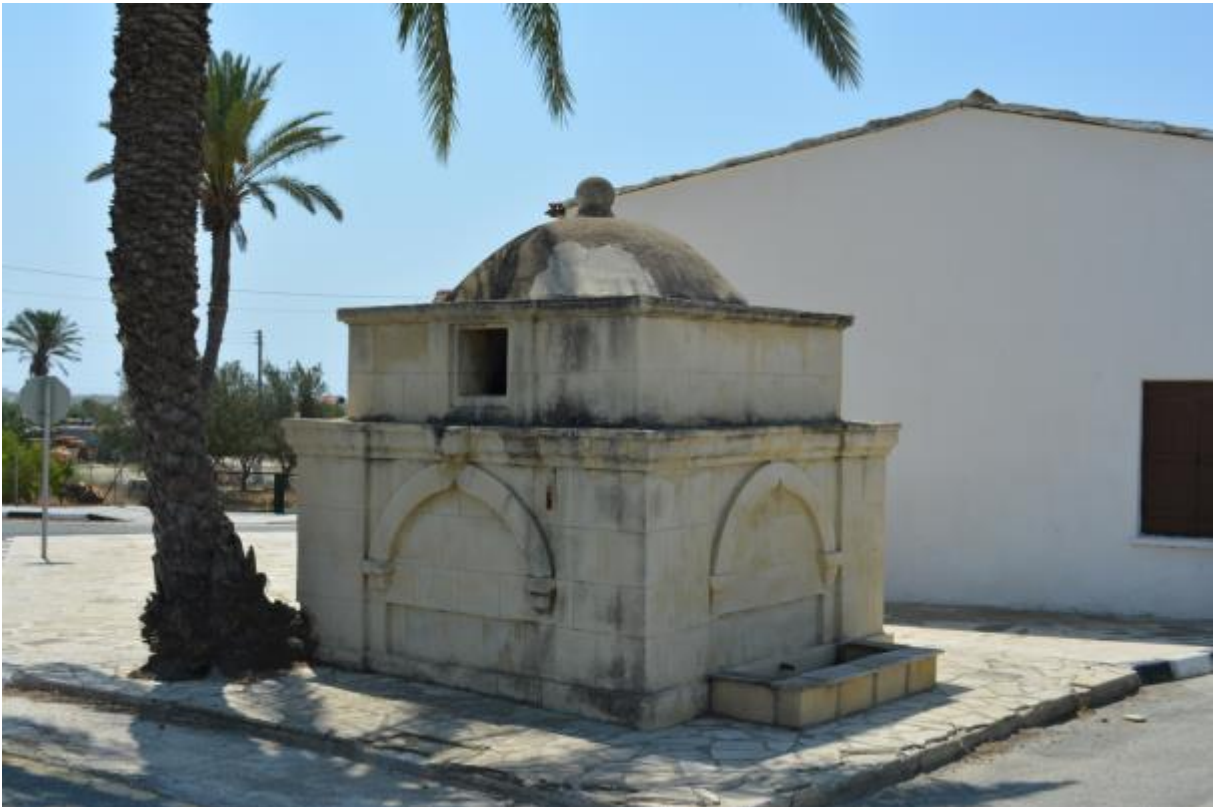
Foto 3.94 Celya Köyü Cami Çeşmesi, Kuzey ve Batı Cepheler
