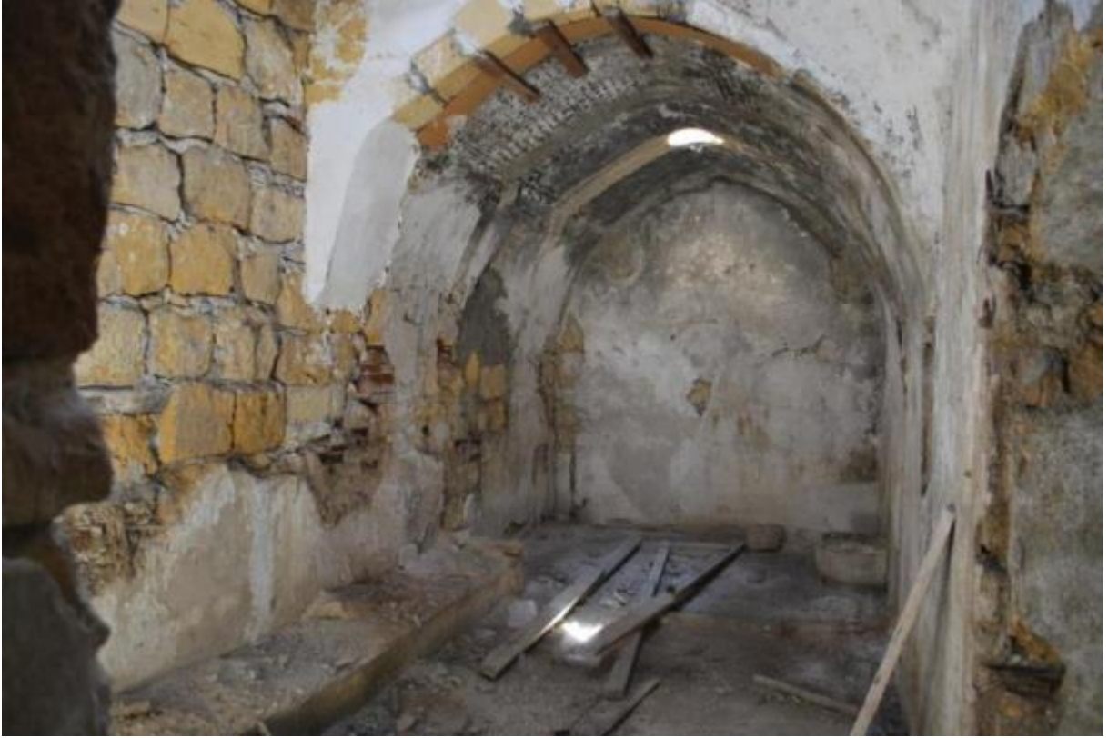
Foto.3.163 Sıcaklığa Geçiş Mekânı
