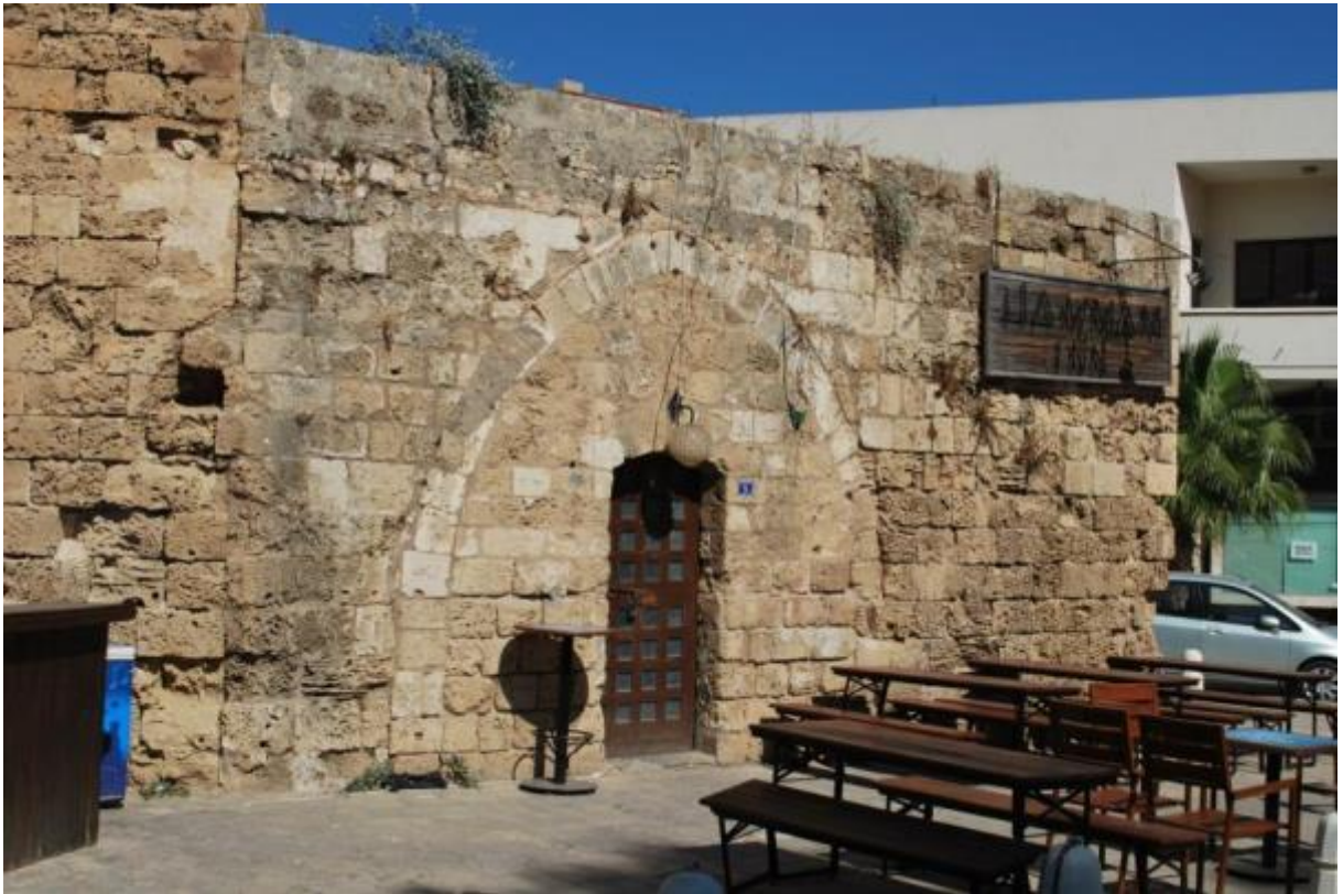
Foto.3.133 Kuzey Cephesi, Giriş
