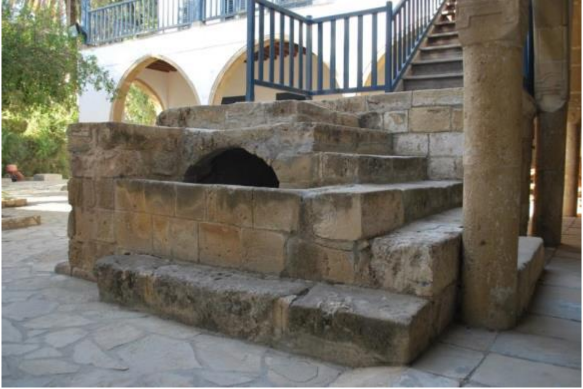
Foto.3.29 Lefkoşa, Derviş Paşa Konağı Çeşmesi, Kuzey Cephe
