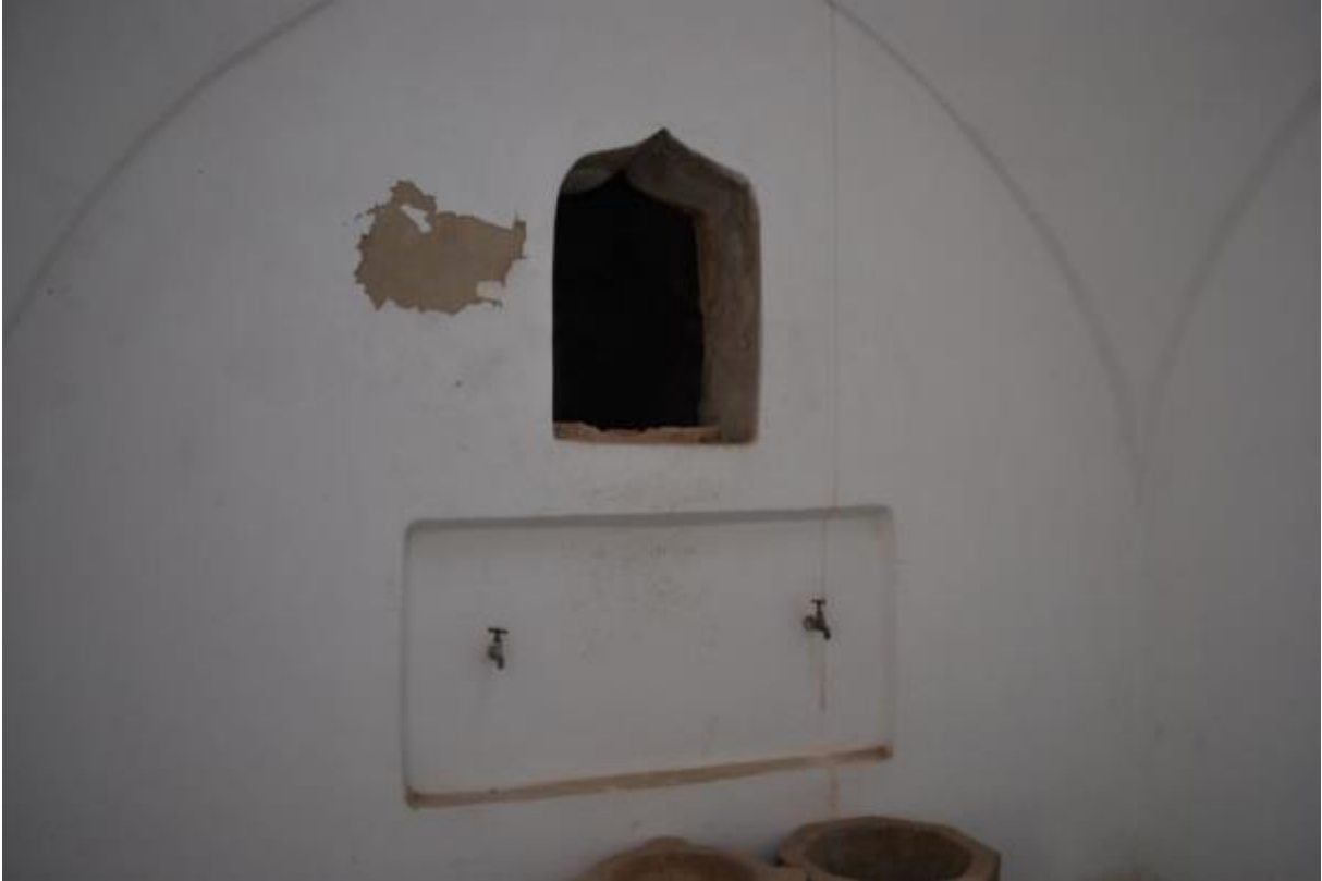
Foto.3.185 Sıcaklık, Musluklar ve Depo Kontrol Penceresi
