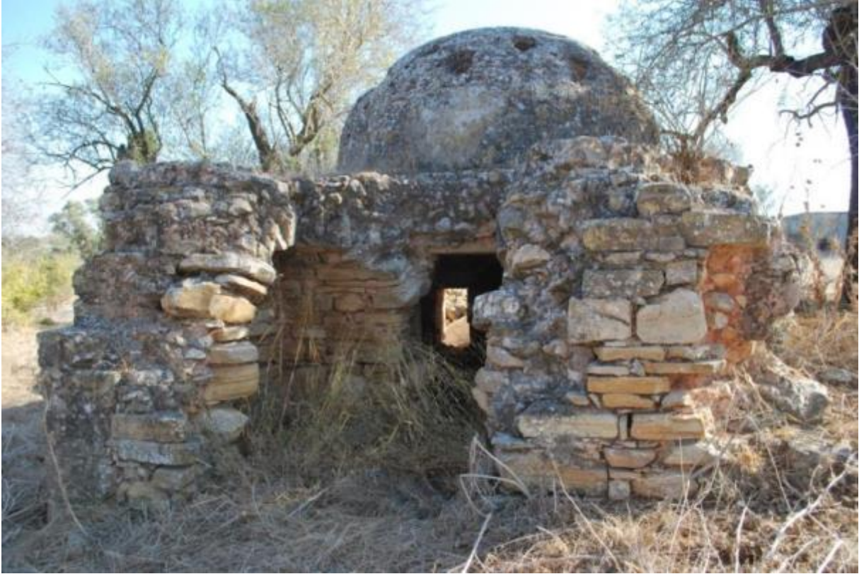
Foto.3.181Hisarköy Hamamı, Su Deposu
