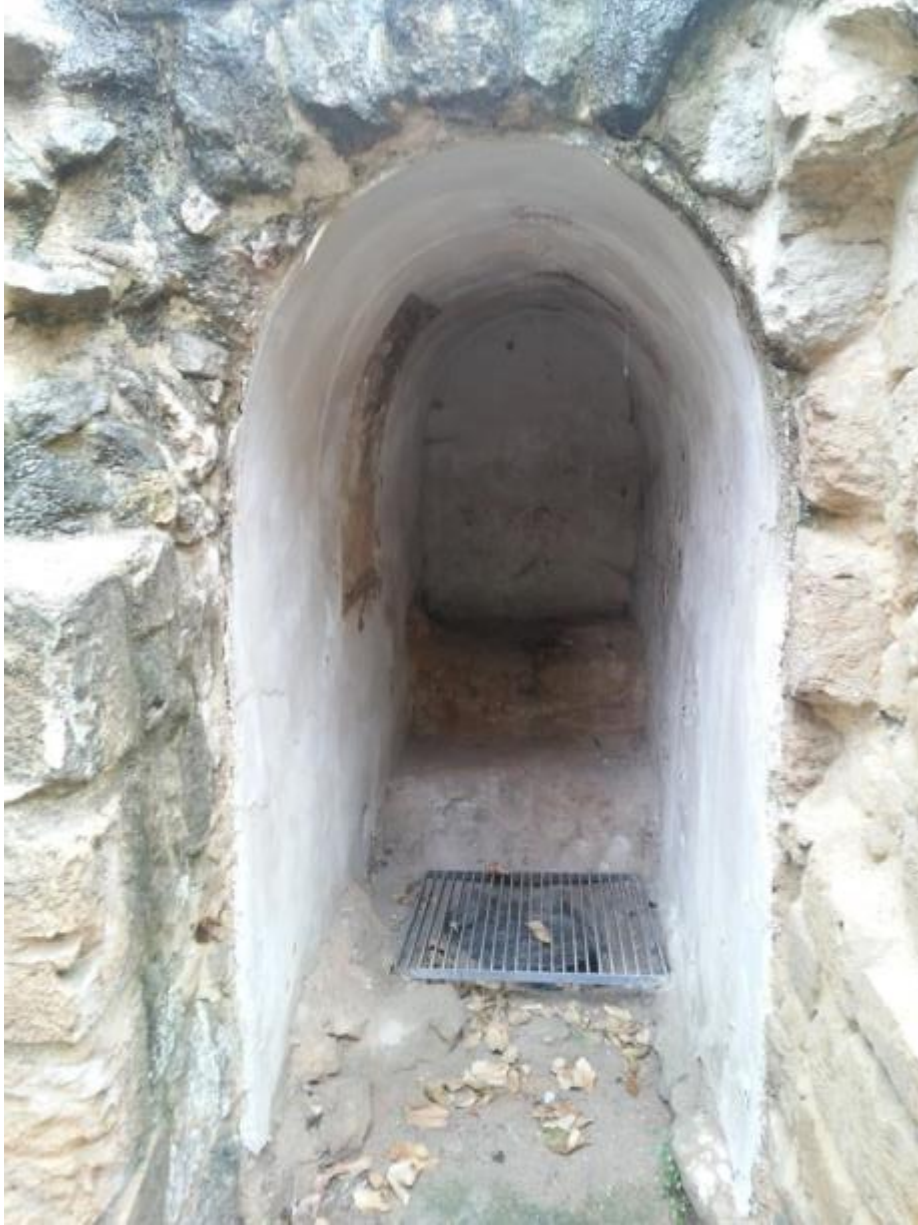
Foto 3.154 Eski Su Deposu
