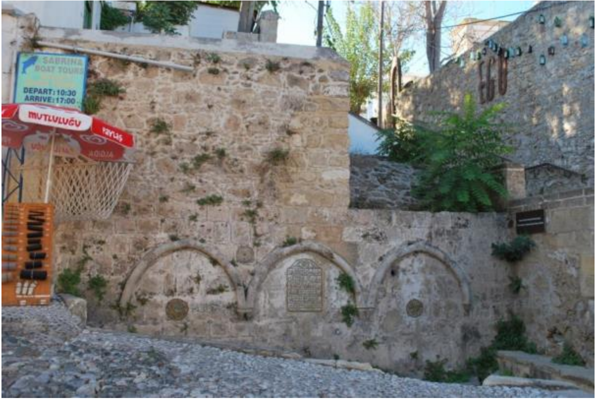
Foto 3.53 Girne Hasan Kavizade Çeşmesi, Kuzey Cephe
