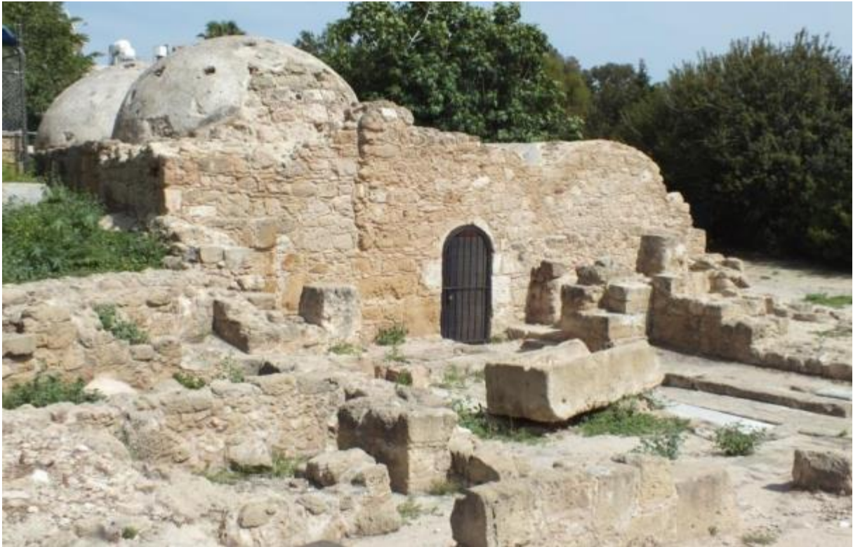
Foto.3.195 Kasaba, Osmanlı Çeşmesi Yanındaki Hamam, Batı Cephesi
