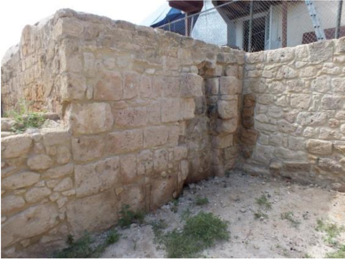
Foto.3.201Su Deposunun Sonradan Kapatılan Külhan Açıklığı
