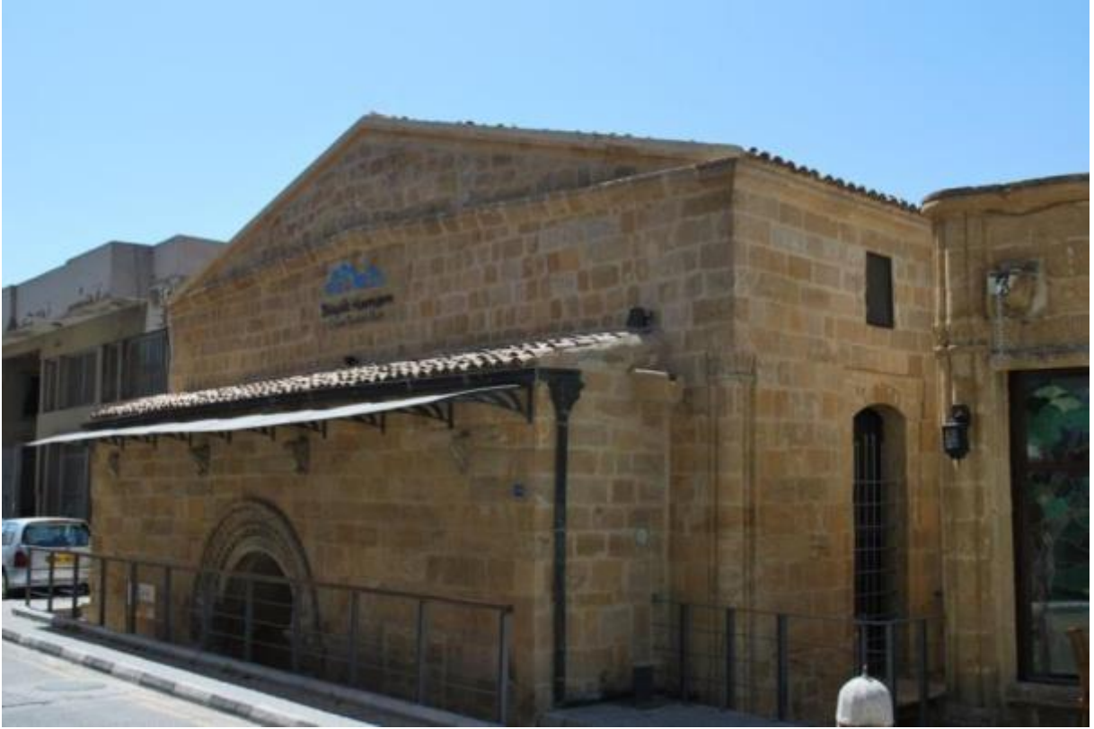
Foto 3.118 Kuzey Cephesi, Giriş Kapısı
