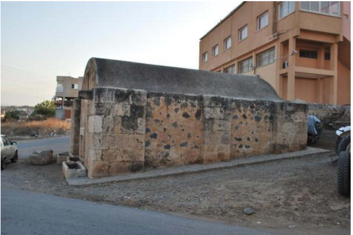
Foto 1.11 Dođancı Sarnıcı Kuzey Cephe
