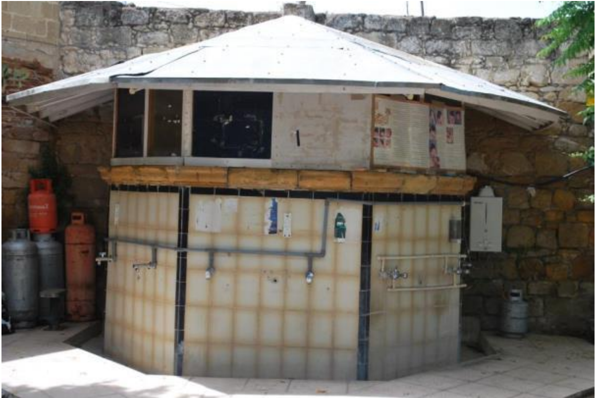
Foto 3.86 Lefkoşa Ömerge Camii Şadırvanı, Kuzey Cephe
