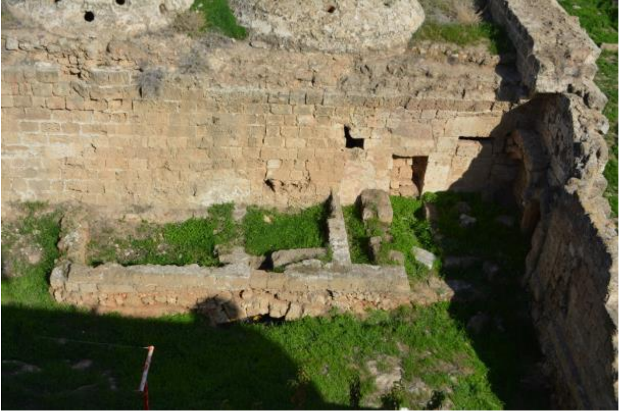
Foto 3.177 Batı Cephedeki Su Deposu ve Ocak
