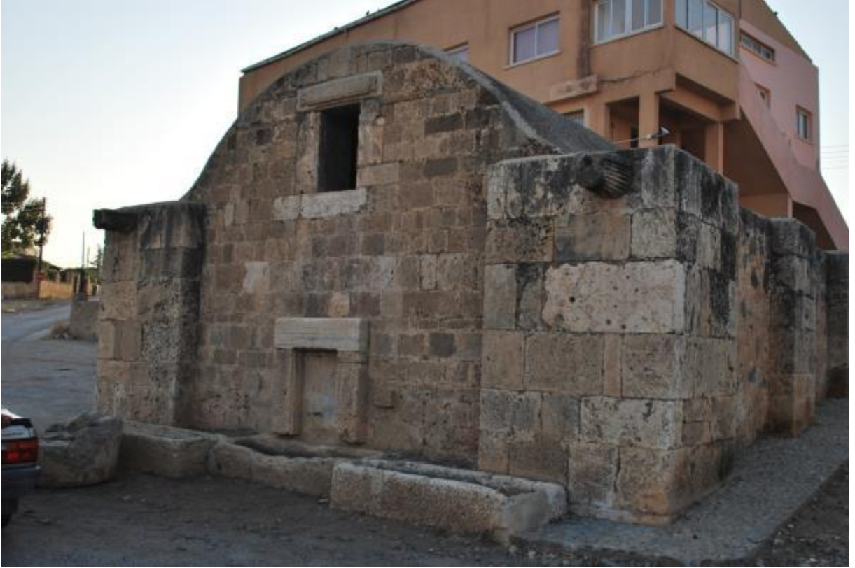
Foto.3.17 Doğanlı Köyü Sarıncı Çeşmesi, Doğu Cephe
