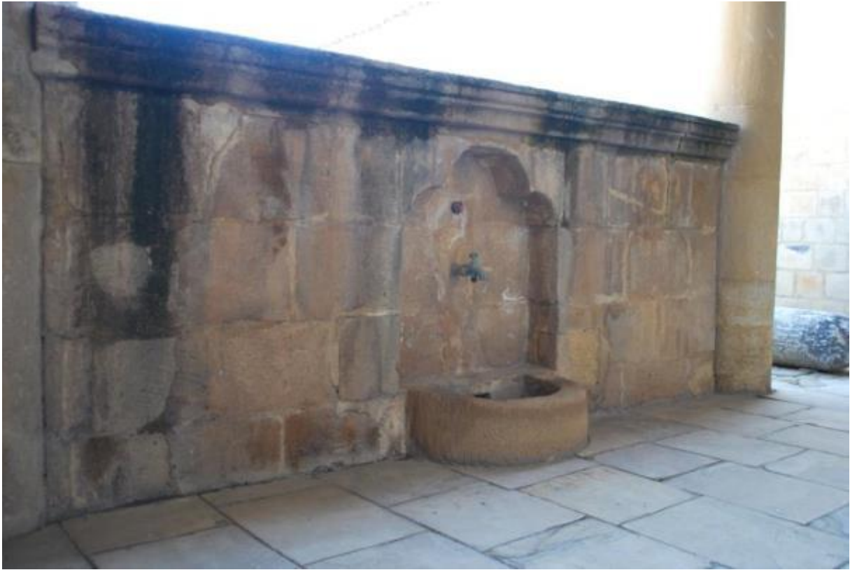
Foto 3.66 Lefkoşa Lüzinyan Evi Çeşmesi, Batı Cephe
