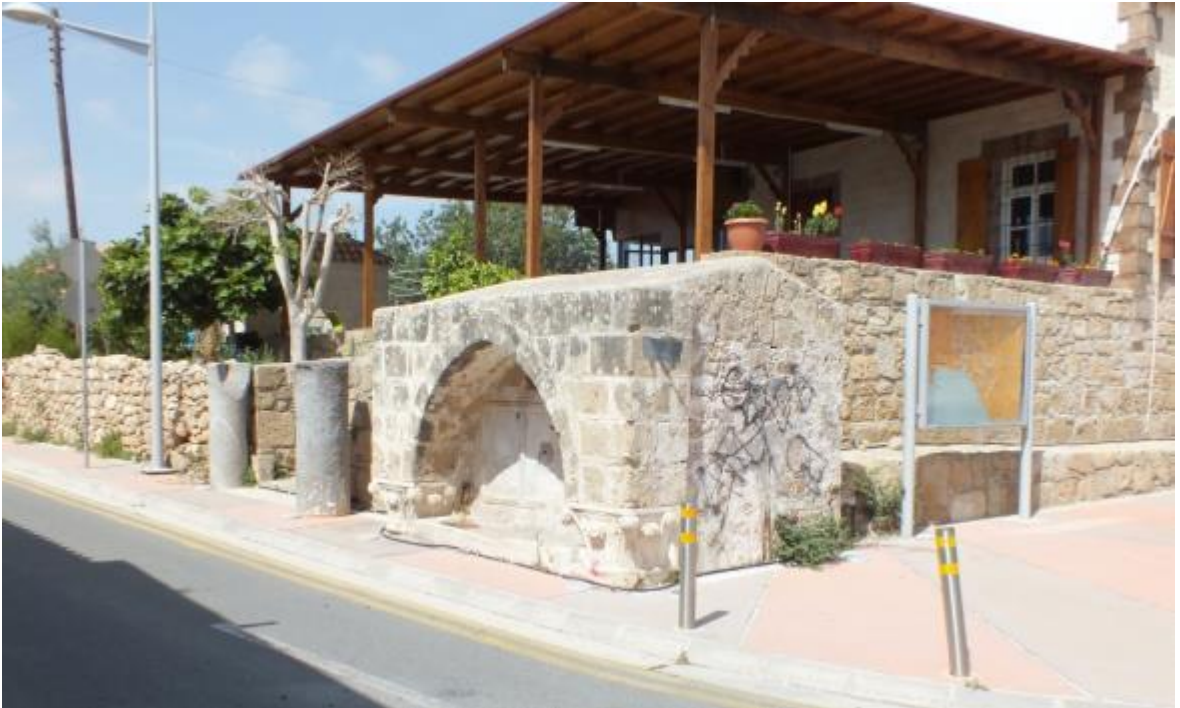
Foto 3.64 Aşağı Baf, Osmanlı Çeşmesi, Kuzey ve Batı Cepheler
