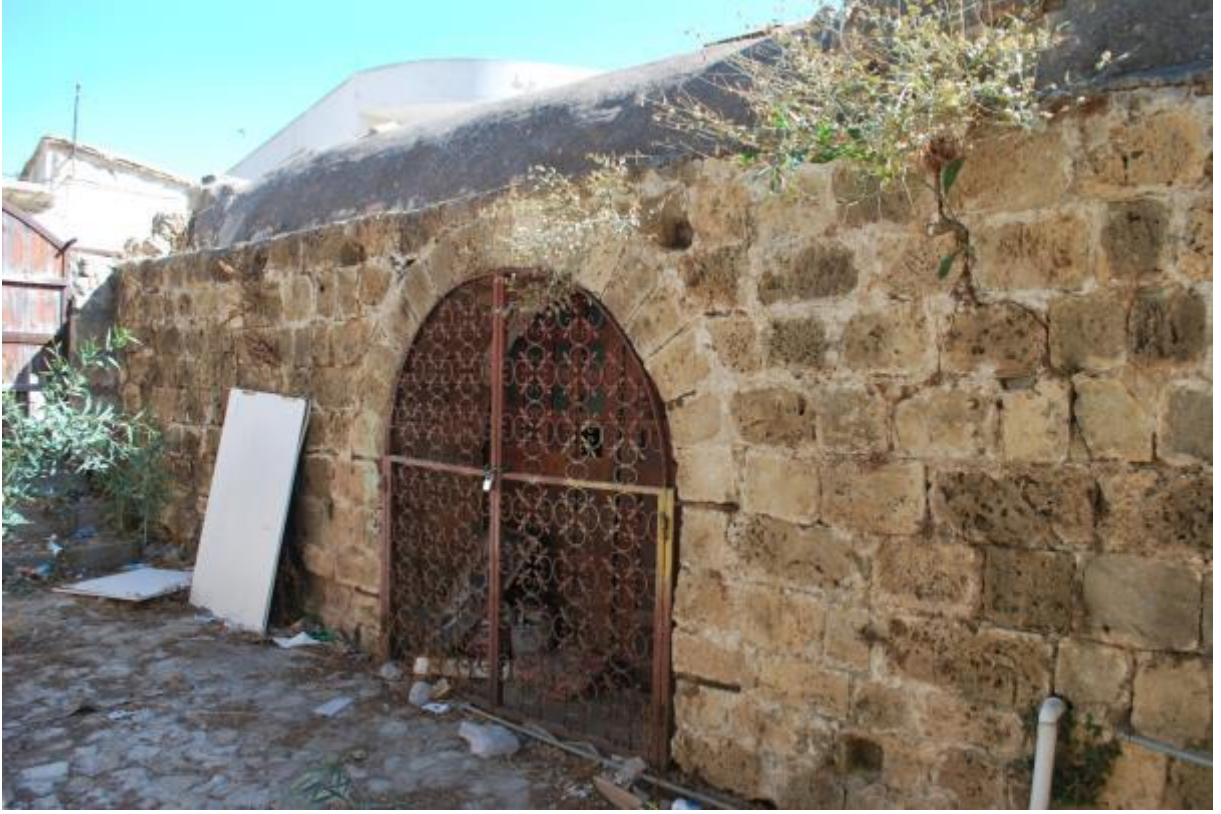
Foto.3.140 Deponun Güneyine Sonradan Açılan Kapı
