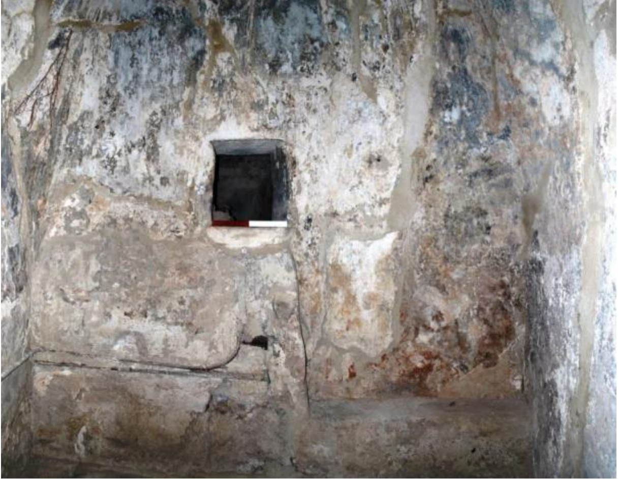
Foto.3.159 Sıcaklık, Kontrol Penceresi
