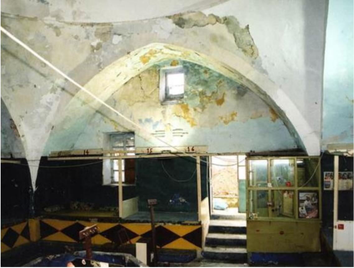
Foto 3.98 Soyunmalık, Güney Duvarı
