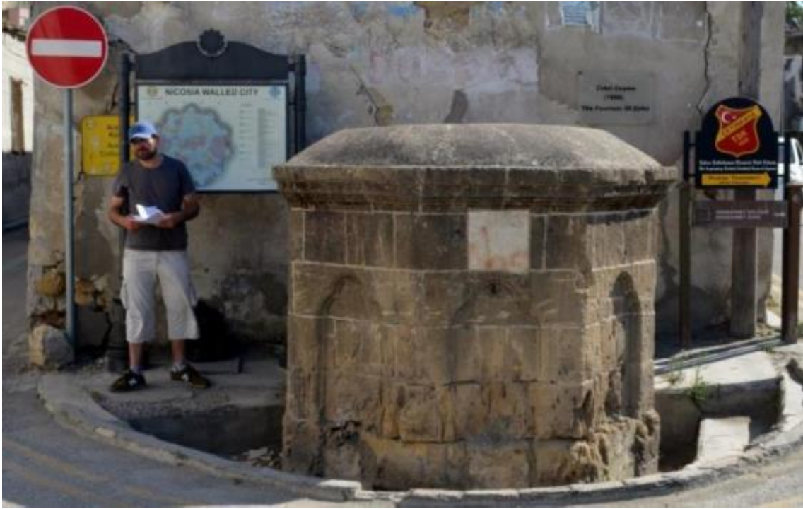
Foto 3.83Lefkoşa Hasan Mutallip Çeşmesi
