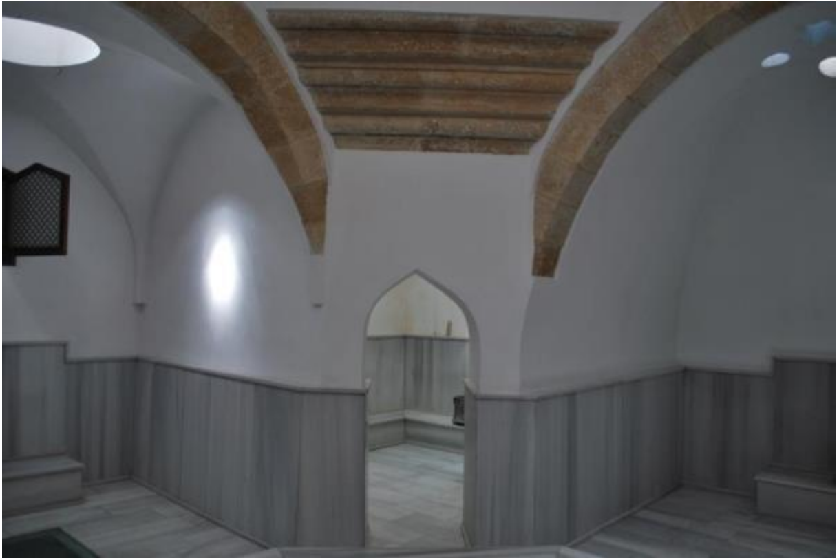
Foto 3.128 Sıcaklık, Pandantif Geçişleri
