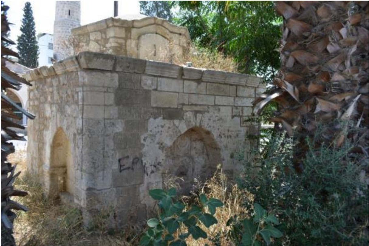
Foto. 3.82 Tuzla Hacı Abdül Hamit Bey Çeşmesi, Kuzey ve Doğu Cepheler
