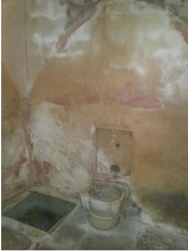
Foto 3.151 Sıcaklık, Kurna ve Musluk Delikleri
