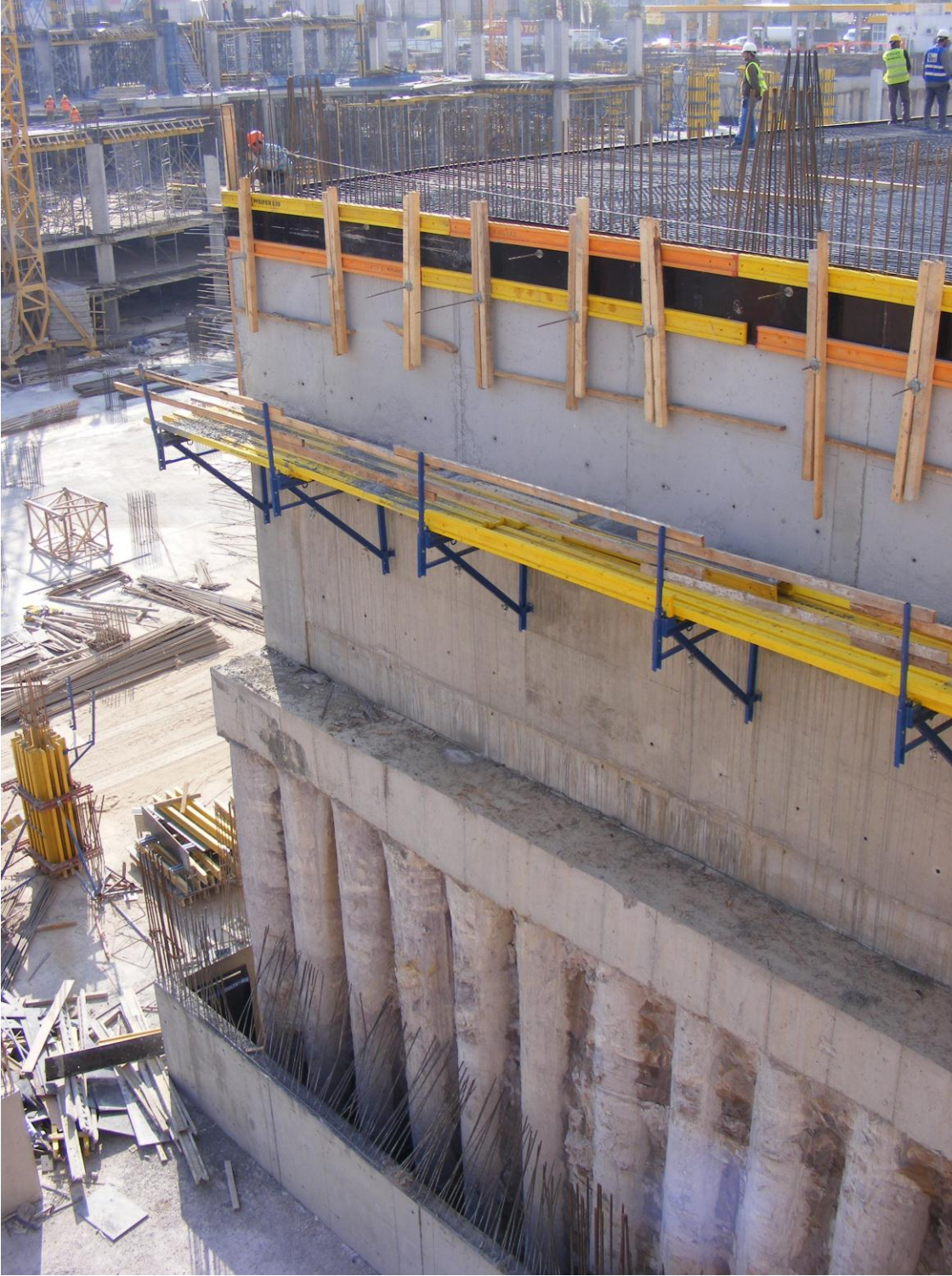
Resim 4.6 : Kalıp yapımı esnasında platform kurulması
