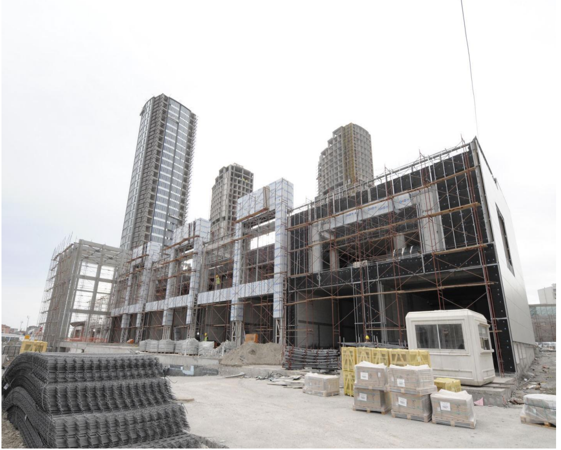
Resim 4.7 : Bina çevresine kurulmuş iş iskelesi
