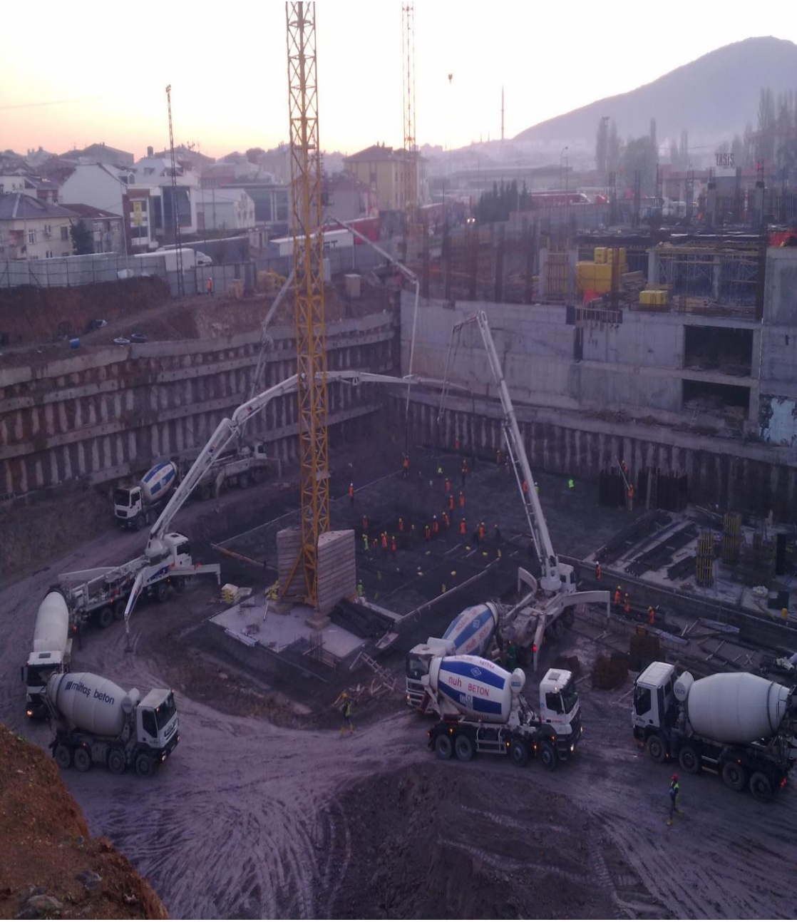
Resim 4.5 : Üç farklı pompa ile temel betonu dökümü
