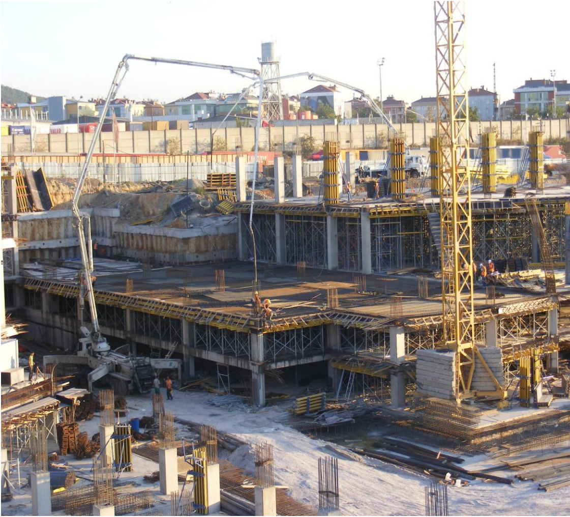
Resim 4.4 : Farklı kotlarda eş zamanlı beton dökümü
