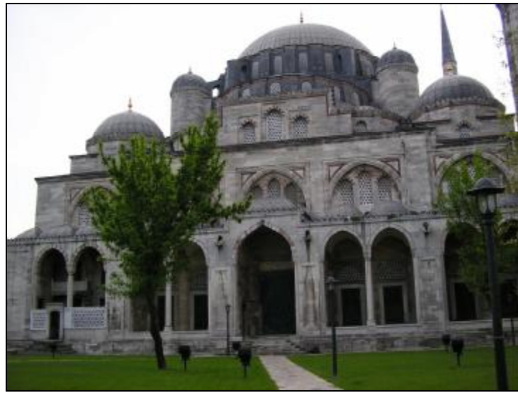
Resim 4. 24. Şehzade M. Camii Revaklı Doğu Cephesi .
