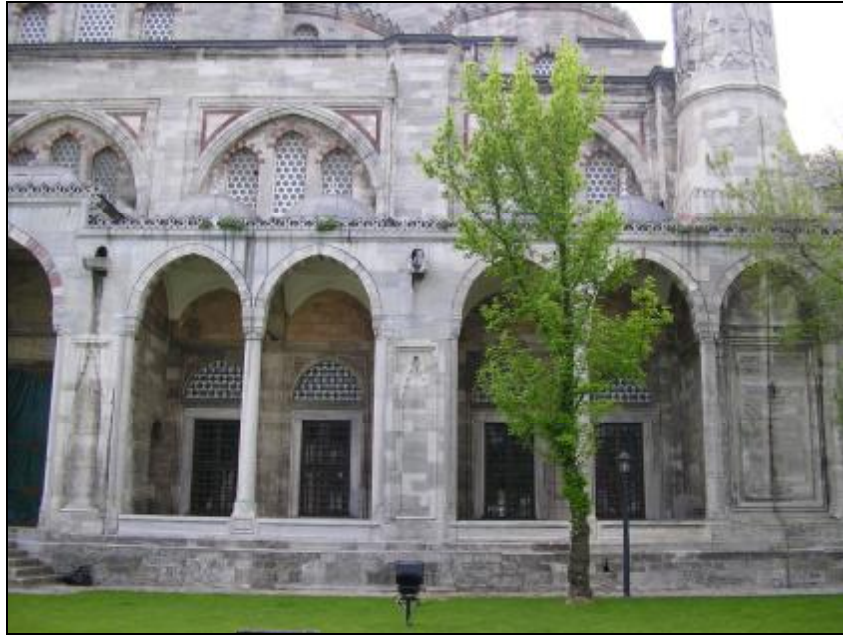
Resim 4. 32. Şehzade M.Camii Minare Kaidesi.
