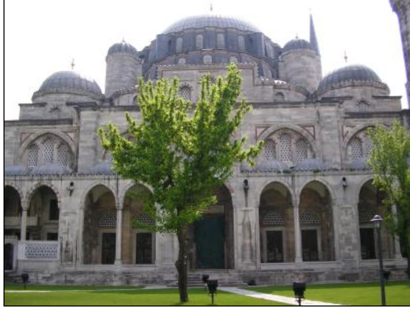
Resim 4. 31. Şehzade M.Camii Revaklı Doğu Cephesi .
