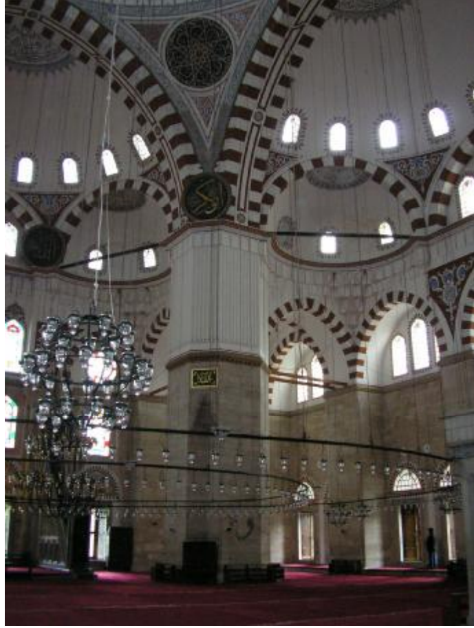
Resim 4. 11. Şehzade M.Camii Taşıyıcı Fil Ayakları.
