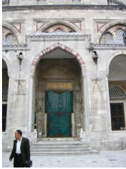
Resim 4. 36. Şehzade M.Camii Batı Cephesi Giriş Kapısı .
