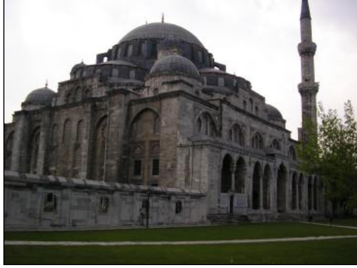
Resim 4. 27. Şehzade M.Camii Mihrap ve Revaklı Doğu Cephesi
