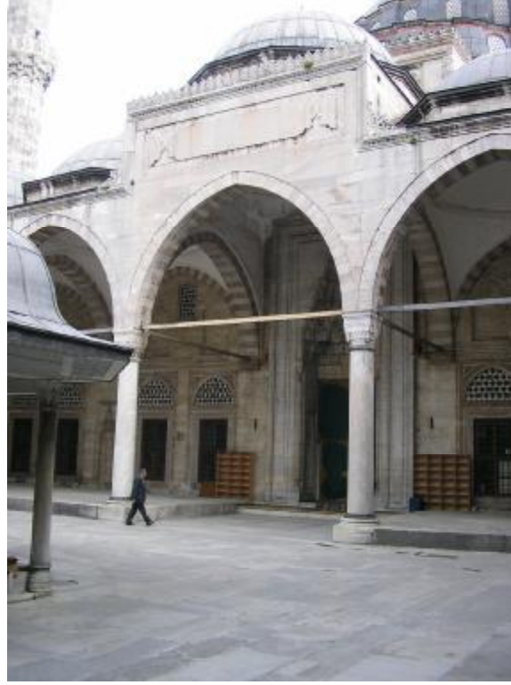
Resim 4. 26. Şehzade M.Camii Son Cemaat Yeri Cephesi .
