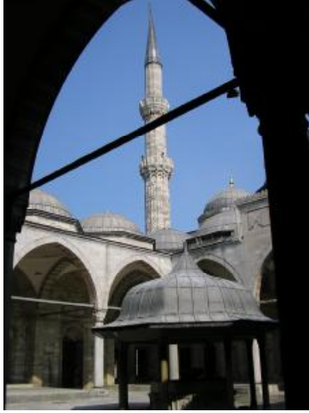
Resim 4. 38. Şehzade M. Camii Avlusu'ndan Minare'nin Görünümü
