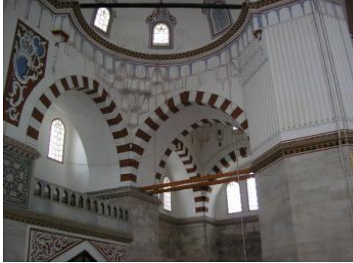
Resim 4. 13. Şehzade M.Camii kuzey duvarında yer alan galeri.
