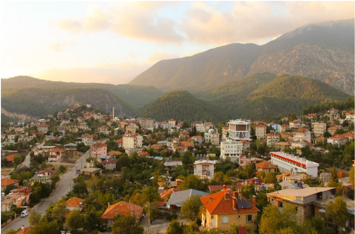
Görsel 3.1 Gündoğmuş İlçesine Genel Bakış
