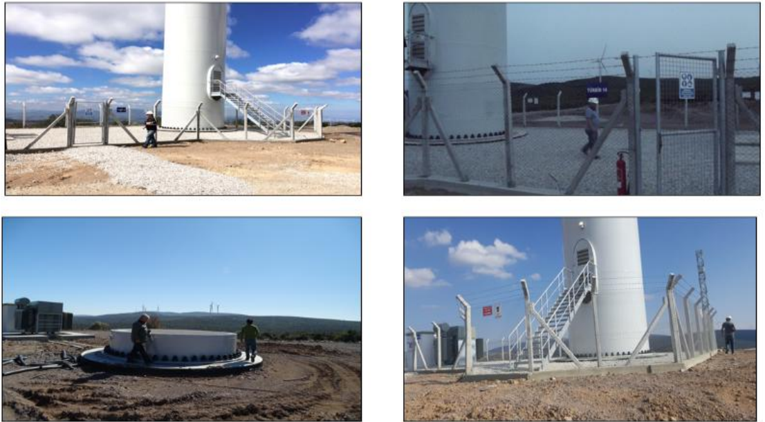
Şekil 3.13. Proje sahasında yer alana türbinlerin çevresinde yapılan karkas tarama faaliyetleri
