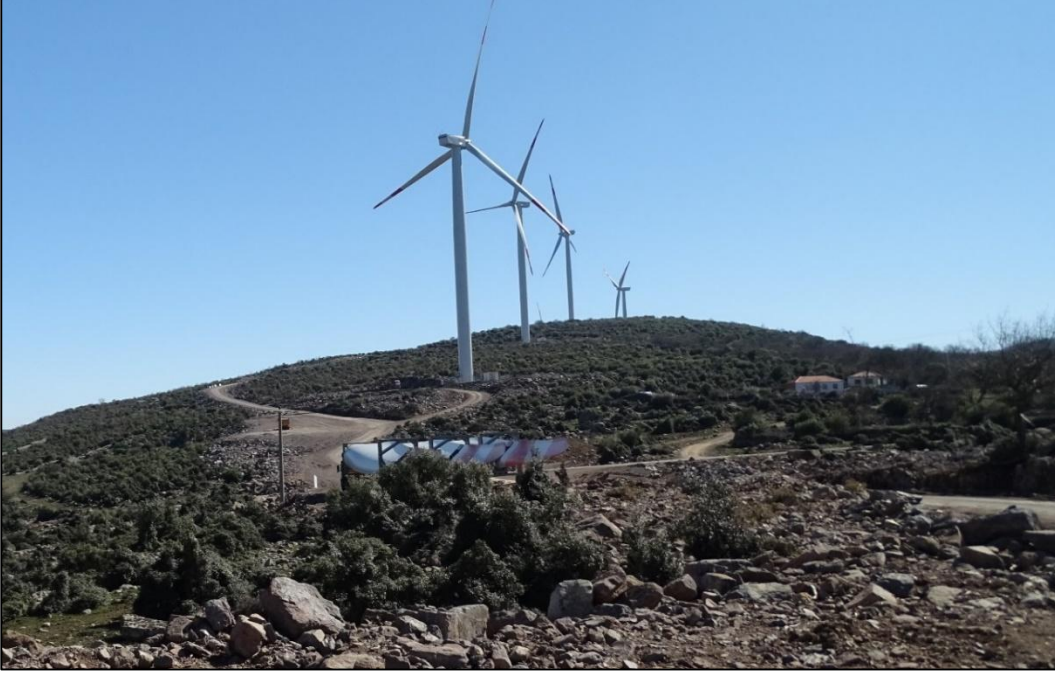
Şekil 5.1. Proje sahasında türbin inşaatı sırasında açılan türbinler arası bağlantı yolları
