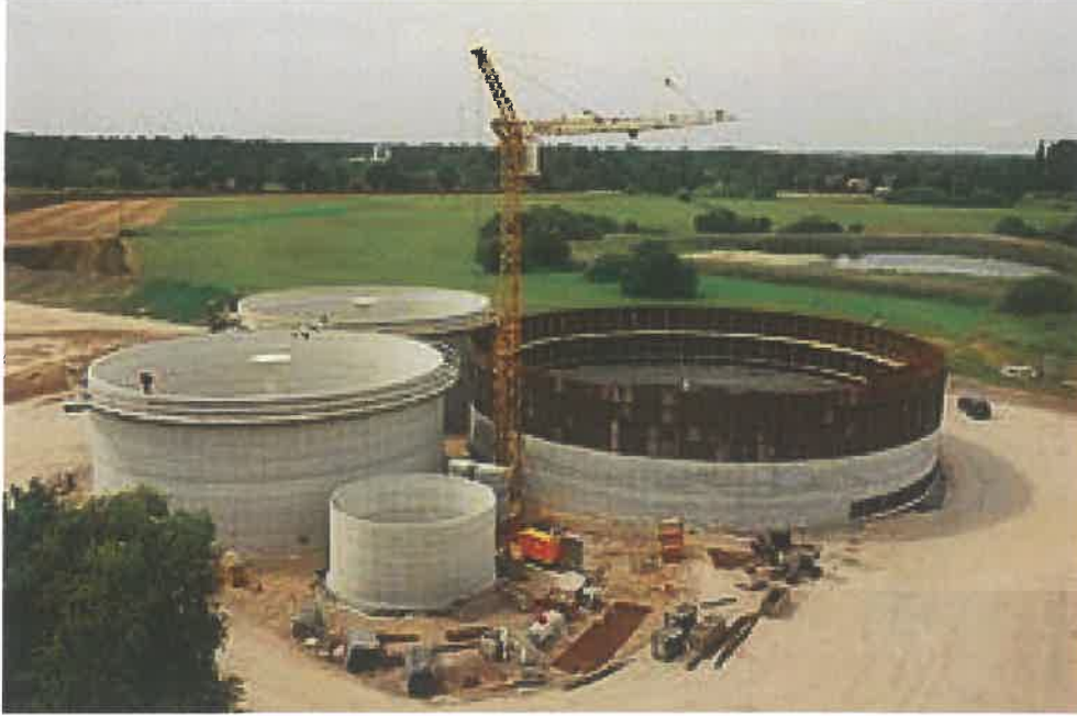
Şekil 4.52. Örnek biyogaz tesisi betonarme inşaatı (Enerji portalı, 2018)
