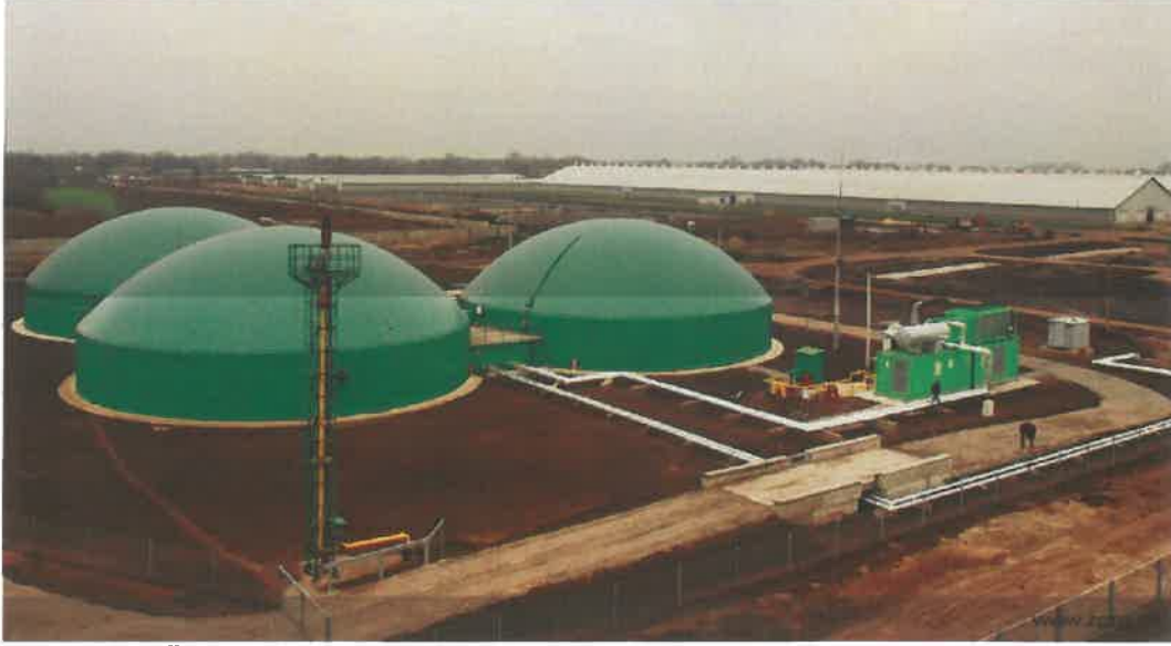
Şekil 4.46. Örnek bir biyogaz tesisi (Enerjiportali, 2018)
