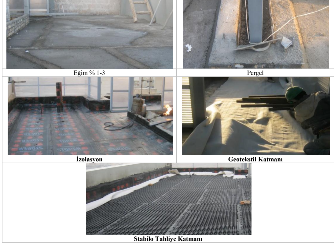
Şekil 4.4. Abbas Abad Avenu Nahid intensif yeşil çatı projesi çatı yalıtımının ana parçaları
