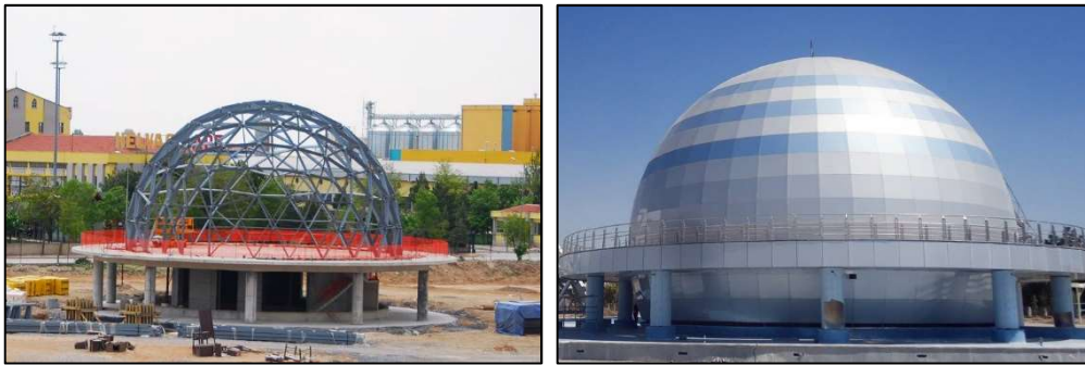
Şekil 3.16. 21 m çaplı jeodezik kubbe, Konya Bilim Merkezi Planetaryum Binası
