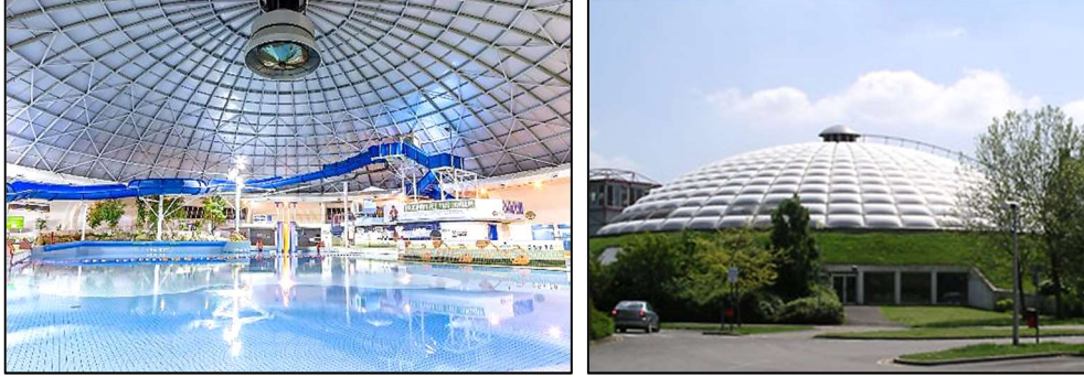
Şekil 3.6. Swindon Leisure Centre, İngiltere
