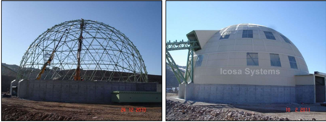
Şekil 3.18. 30 m çaplı jeodezik kubbe, Kışladığı Altın Madeni, Uşak
