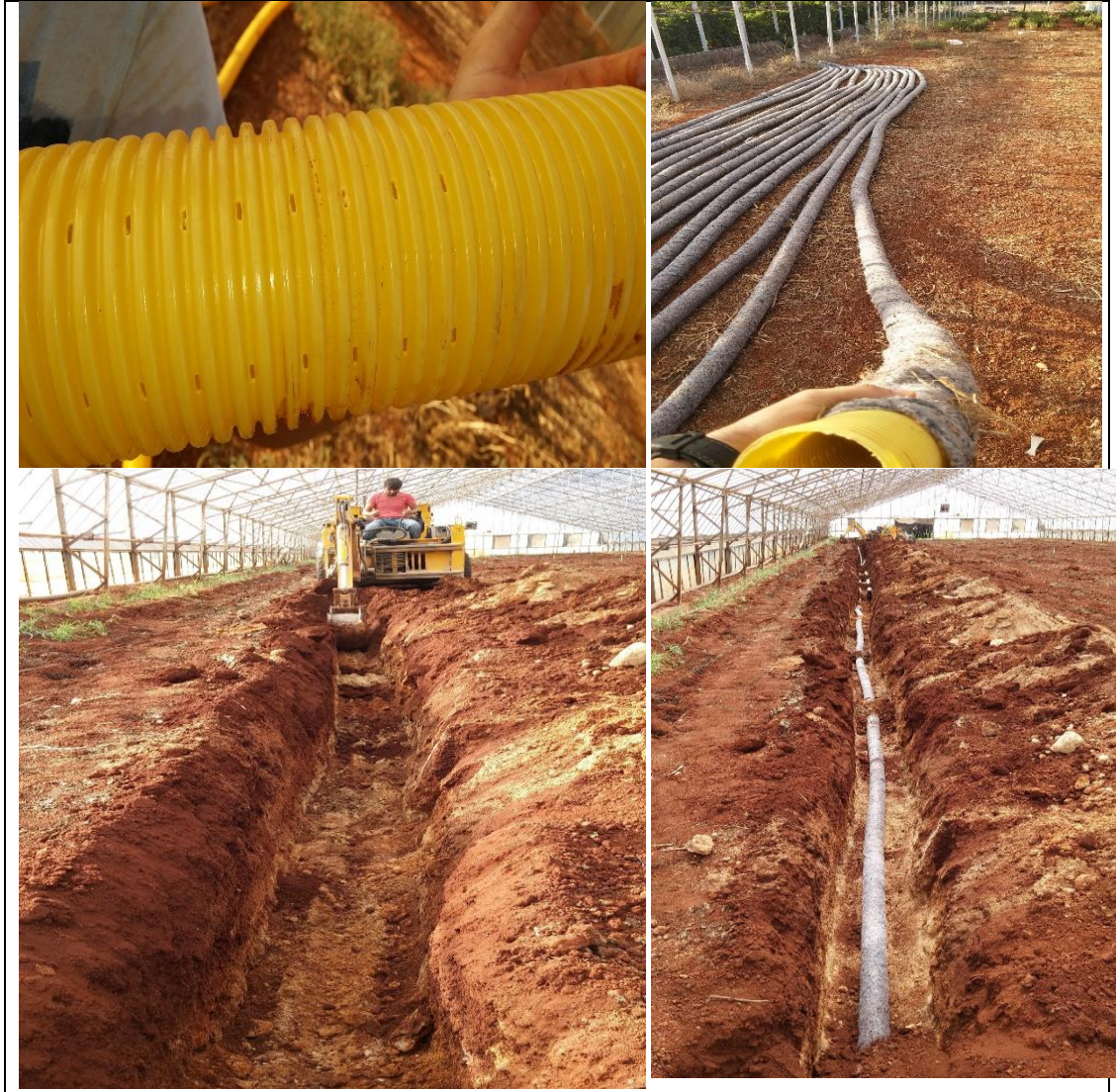
Şekil 3.2. Drenaj boru hattı uygulama fotoğraf gösterimi
