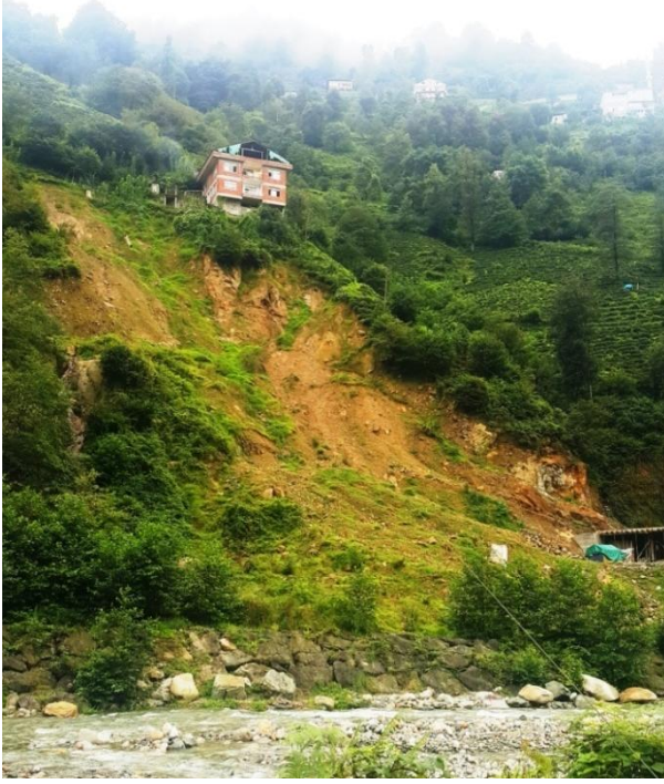
Şekil 3.14. Çalışma sahasında izlenen sığ heyelanlara ilişkin örnek fotoğraf; yenilme evin hemen altında gerçekleşmiştir
