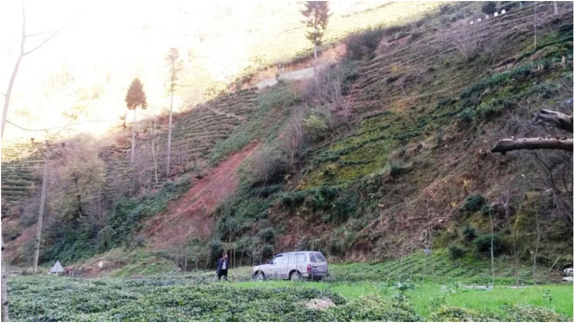
Şekil 3.19. Çalışma sahasında yersel kontroller sırasında izlenen sığ heyelanlara ilişkin örnek fotoğraf; Başköy
