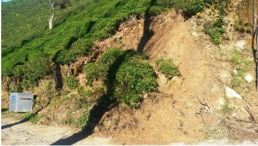
Şekil 3.16. Çalışma sahasında izlenen sığ heyelanlara ilişkin örnek fotoğraf; Güneysu
