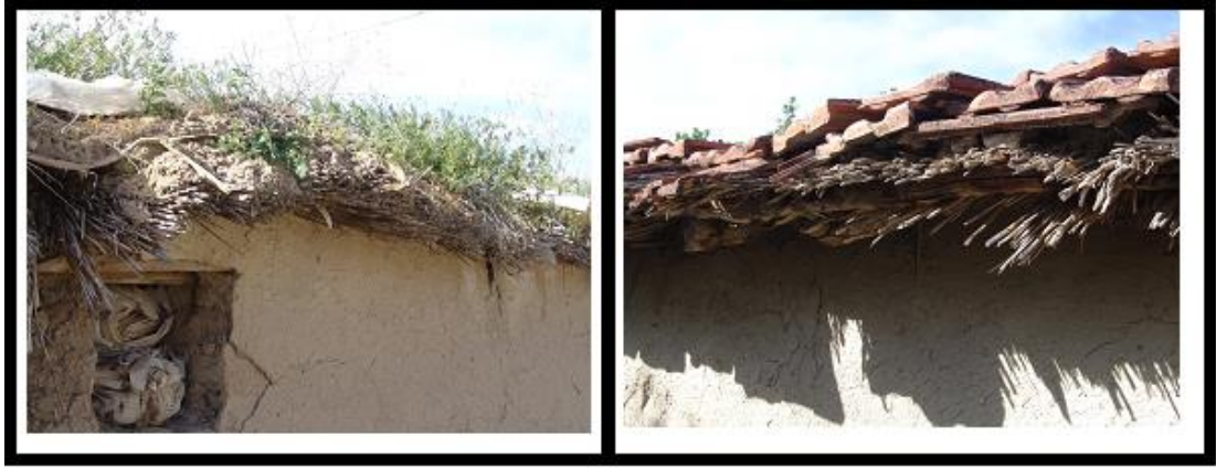
Fotoğraf 3.19. Saz Örtü Duvar Üzerlerinin Nemden Korunması İçin ve Her Türlü Çatı Örtüsünde İzolasyon İçin Kullanılmaktadır
