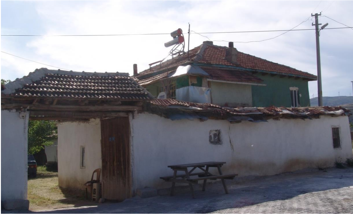
Fotoğraf 3.13. Kanatlı Kapı ya da Çatal Kapı Avluya Her Türlü Aracın Girişi İçin Oldukça Geniş Bir Yapıya Sahiptir
