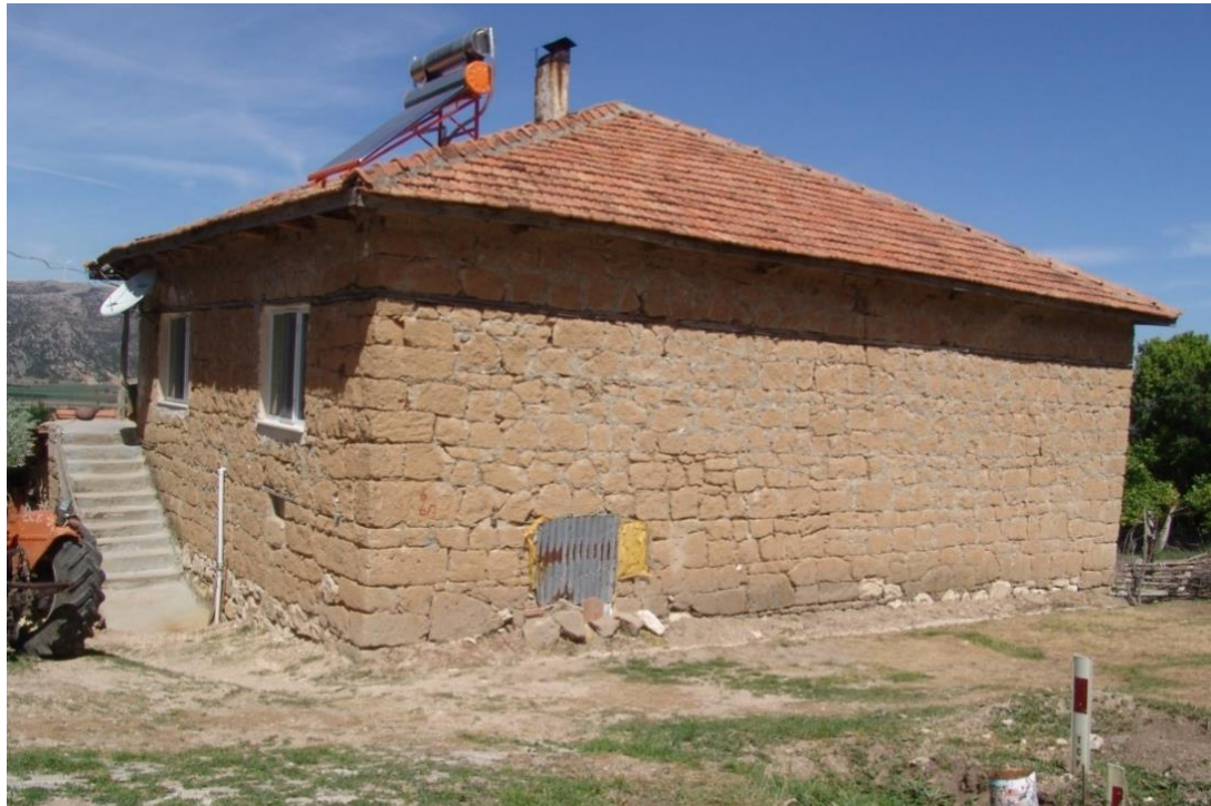
Fotoğraf 3.20. İncesu Köyünde Tamamen Taştan Yapılmış Altı Ahır ve Samanlık Olan Geleneksel Mesken
