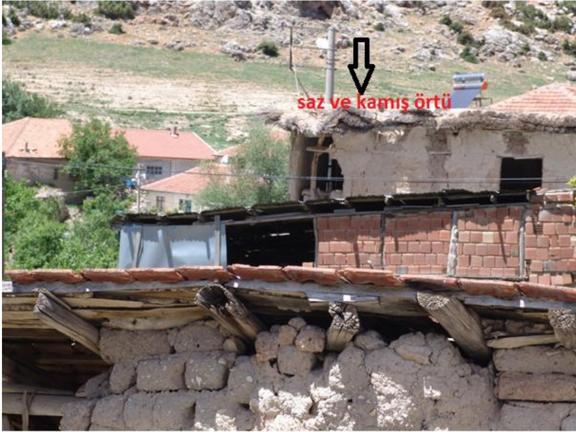
Fotoğraf 3.21. Geleneksel Yapılarda Düz Toprak Çatılarda Sıcaklık Yalıtımı ve Rutubeti(Nem) Önlemek İçin Toprağın Altına Kamyş Döşenmiştir
