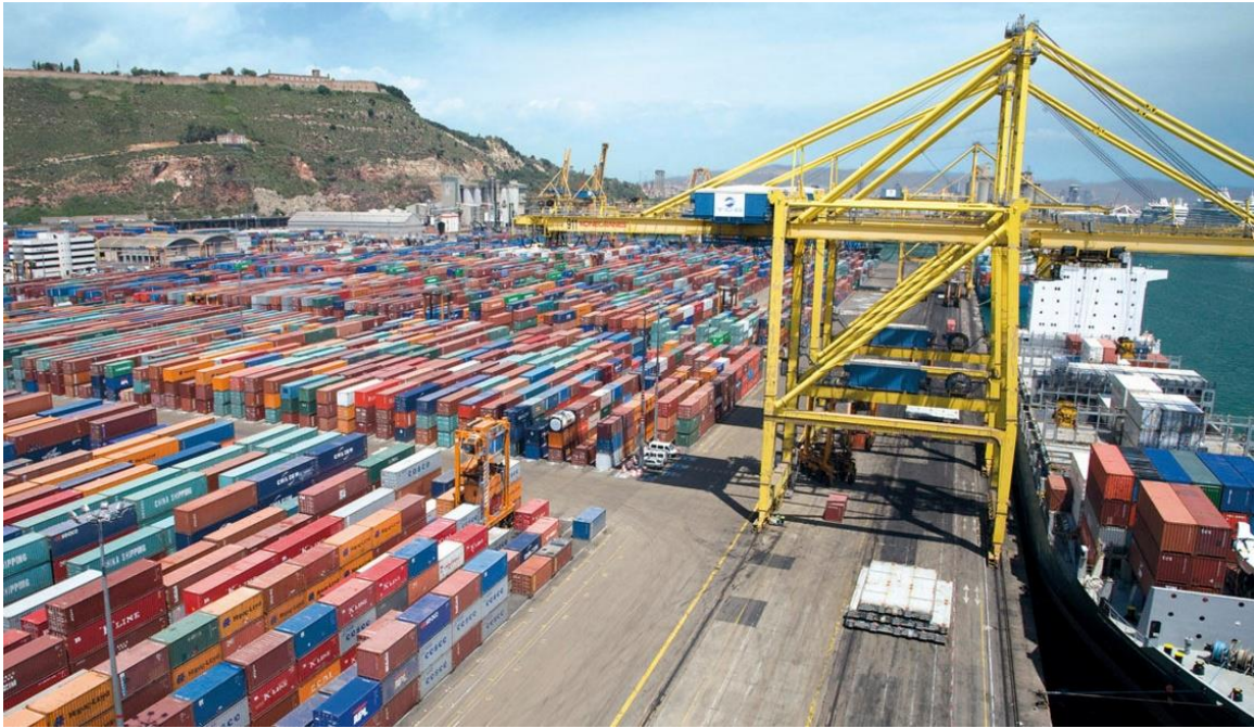
Şekil 3.25 Raylı Sistem Rıhtım Vinci (Ship to Shore Gantry Crane) 318
