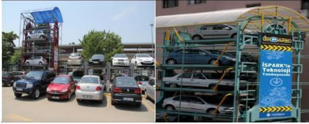
Şekil 2.11. İSPARK dönme dolap otopark sistemleri – istanbul (www.ispark.com.tr)
