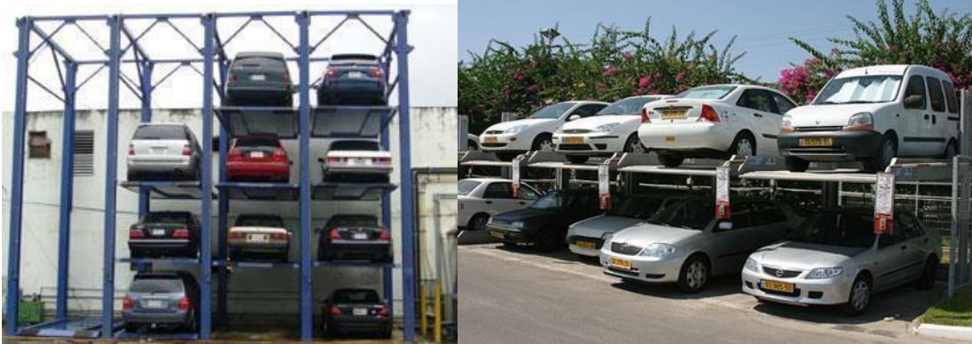
Şekil 2.9. Kapasite artırmaya yönelik elektro-mekanik platformlar ( http://www.flickr.com )
