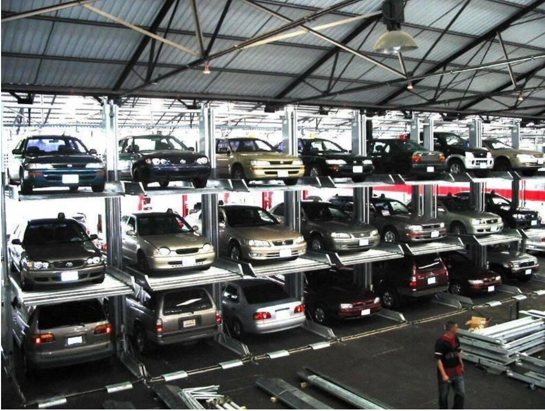
Şekil 2.9. Kapasite artırmaya yönelik elektro-mekanik platformlar ( http://www.flickr.com )
