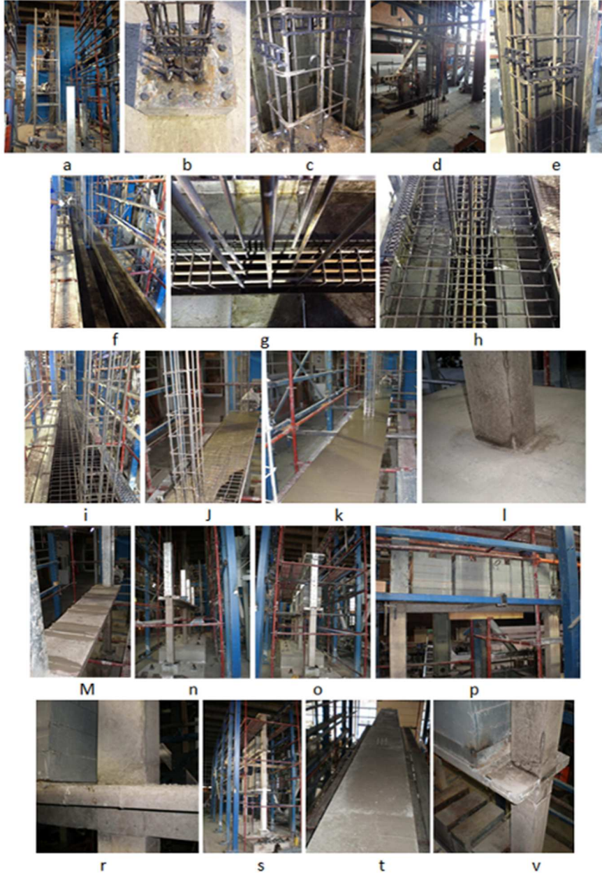
Şekil 3.2. TUBİTAK 112M820 nolu proje kapsamında test edilen deney elemanın yapım aşaması
