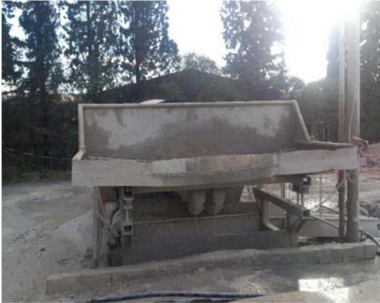
Şekil 2.6.c) Santral gezisinde çekilen beton boşaltım oluğu
