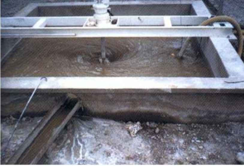
Şekil 2.7. Atık su karıştırıcı (Çoşkun 2007)
