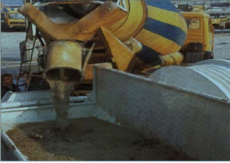
Şekil 2.5. Beton boşaltım oluğu (Coşkun 2007)
