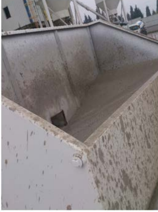
Şekil 2.6.b) Santral gezisinde çekilen beton boşaltım oluğu
