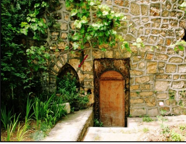
Şekil 4.46. Hamam'ın güney cephe duvarı üzerindeki niş (Orijinal 2015)
