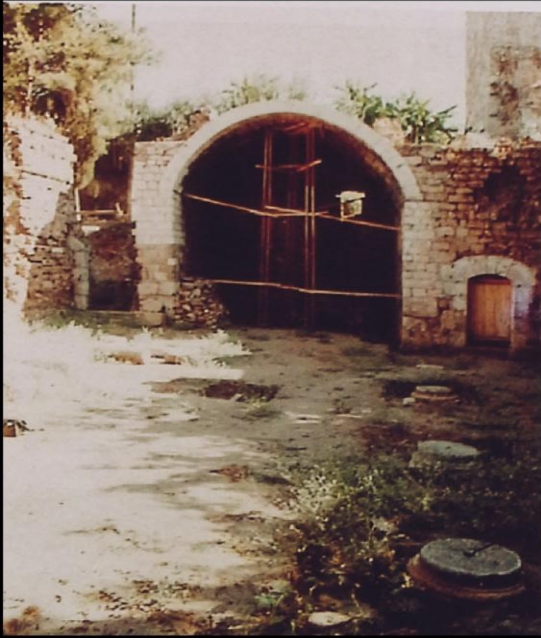
Şekil 4.95. İmaret Medresesi beton sömeller (Yılmaz 2002)
