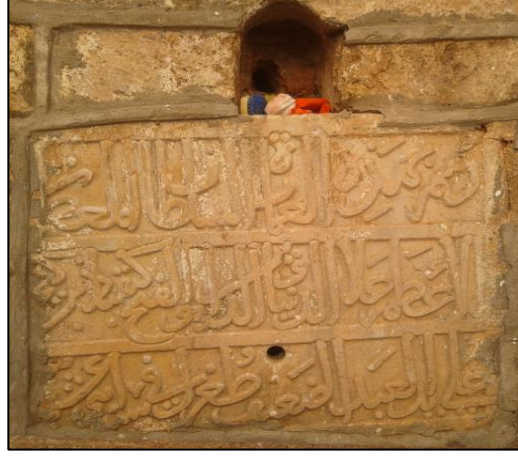
Şekil 4.47. Hamam yapısının doğu cephesindeki kitabe-çeşme (Orijinal 2015)
