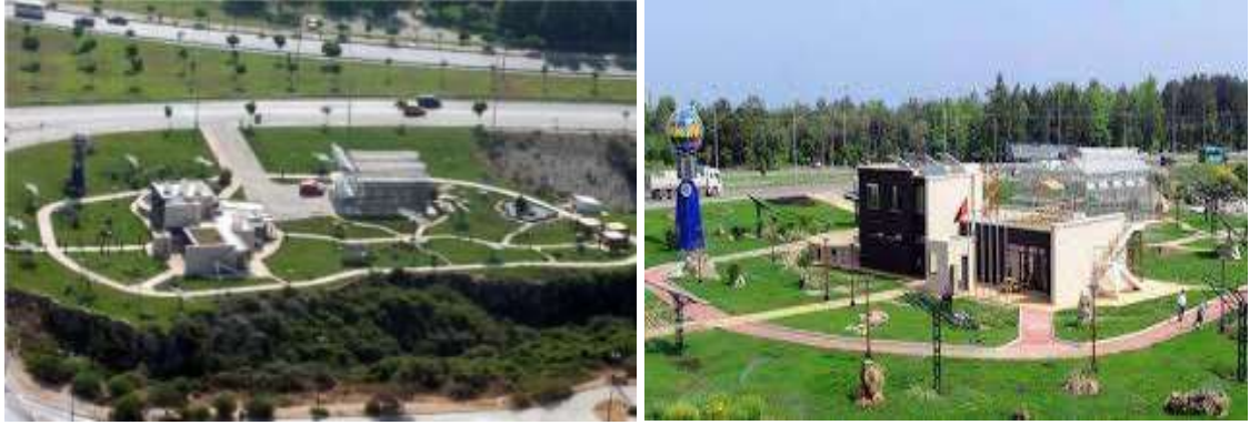
Şekil 4.10. Güneş ev genel görünüşü (Anonim 2012a)
