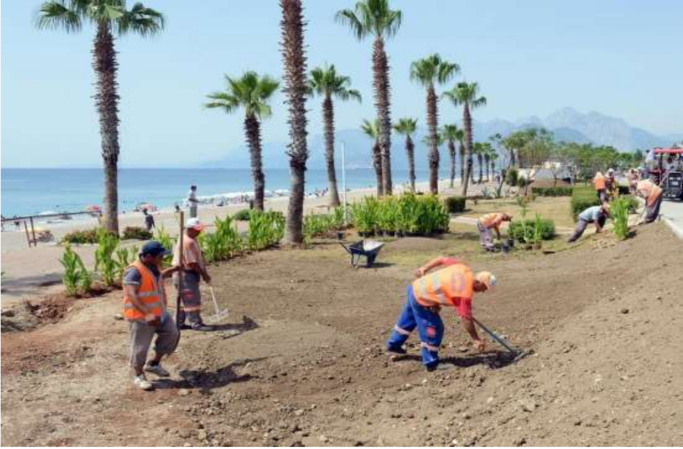
Şekil 4.17. Konyaaltı Batı Plajları düzenleme çalışmaları (Anonim 2014j)
