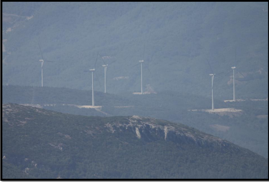
Şekil 5.2. Belen Geçidi'nde kurulu olan türbinlerin uzaktan görünümü
