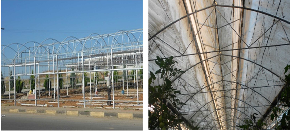
Şekil 4.21: Serik İlçesinden Gövde İskeleti Örneği
