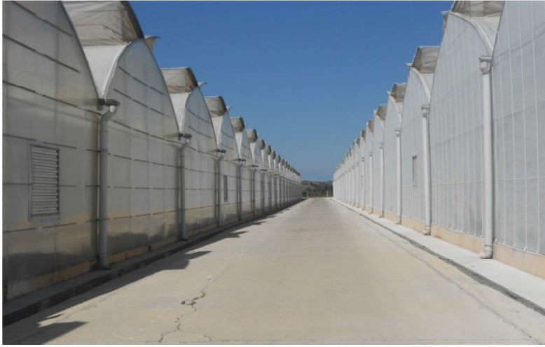
Şekil 4.20: Topraksız Tarım İşletmesi Gotik Tarzı Bitişik Oluk Çatılı Sera
