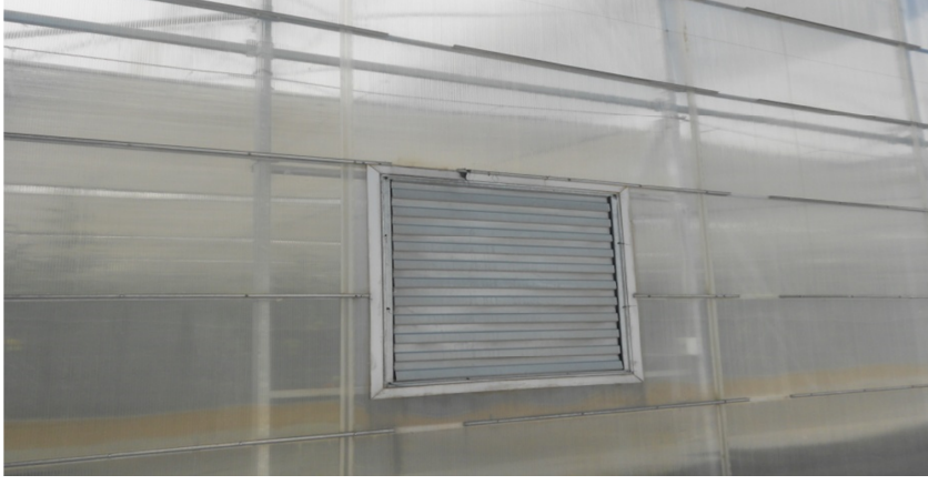
Şekil 4.28: Yan Yüzeyi Polikarbon olan Topraksız Serada Fan-Pad
