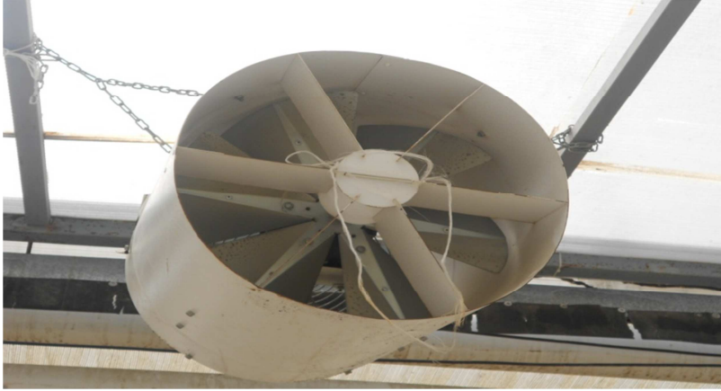
Şekil 4.29: Topraksız Serada Havalandırmada Kullanılan Aspiratör
