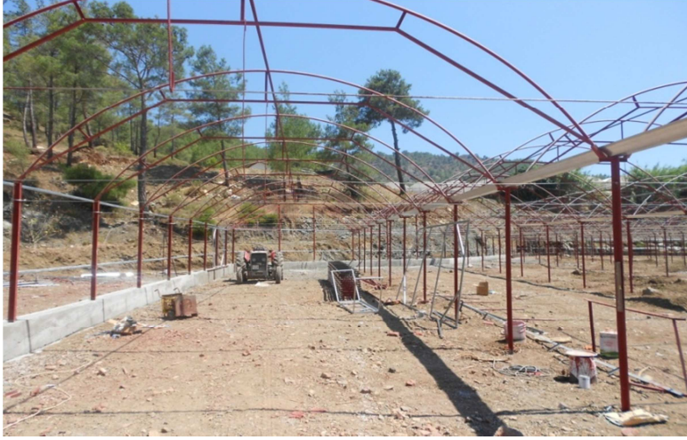
Şekil 4.19: Bitişik Tünel Tipi Geleneksel Plastik Sera
