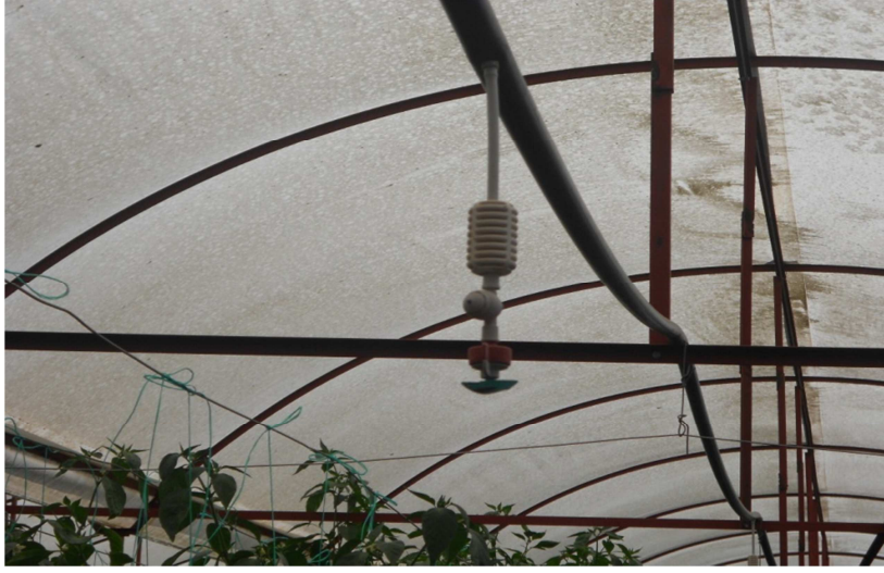
Şekil 4.30: Kumluca Bölgesinde Seralarda Kullanılan Sisleme Ünitesi
