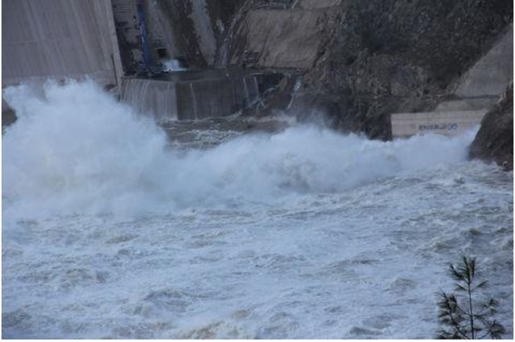
Şekil 2.26. Adana'nın Kozan İlçesindeki Gökdere Barajının, Derivasyon Tüneli kapağının patlaması sonucu meydana gelen sel (Habertürk 2012)
