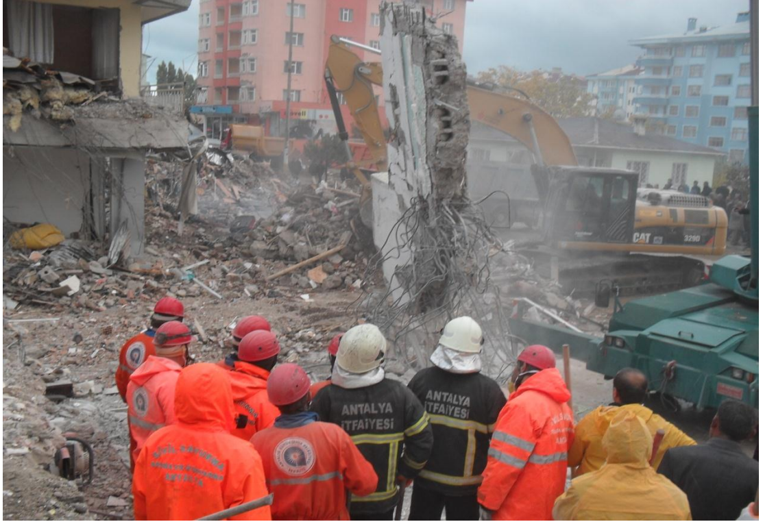
Şekil 2.16. 23 Ekim 2011 Van depremi sonrası enkaz kaldırma çalışmaları (Antalya Büyükşehir Belediyesi İtfaiye Dairesi Başkanlığı)
