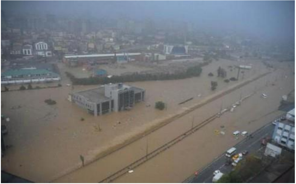
Şekil 2.24. İstanbul’da Ayamama Deresi’nde oluşan şehir seli (BİA Haber Merkezi 2009)
