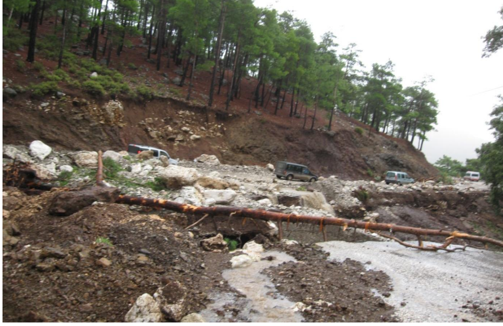
Şekil 2.30. Haskızılören yakınlarındaki Hasgebe mevkiinde sel nedeniyle meydana gelen yol göçmesi (Antalya Büyükşehir Belediyesi İtfaiye Dairesi Başkanlığı 2011)
