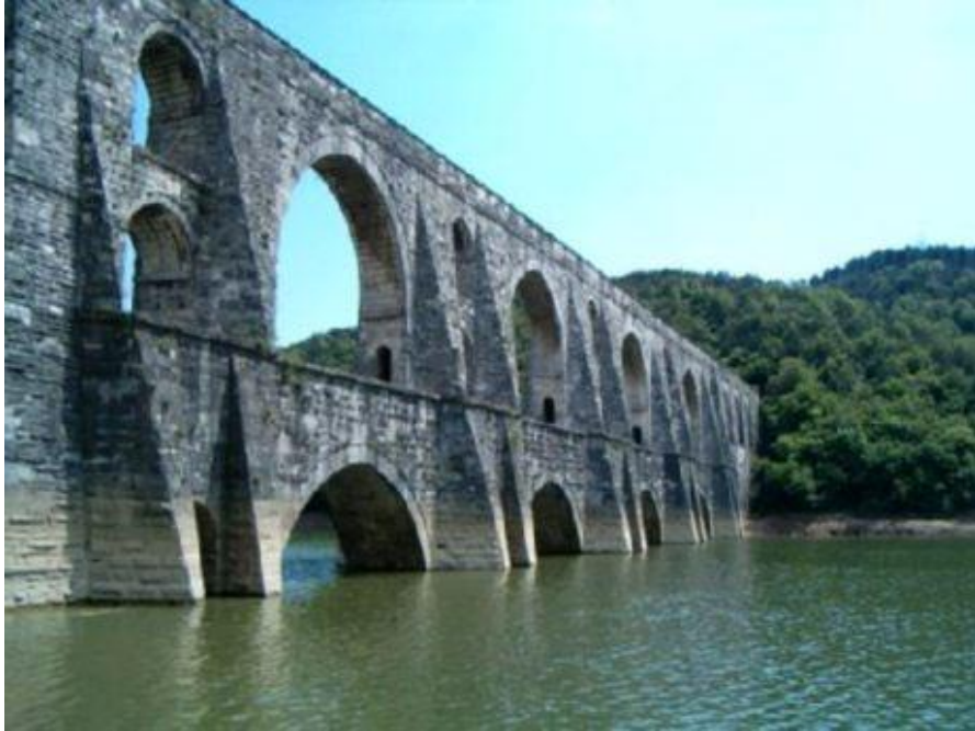
Şekil 2.39. Alibey Barajı'nın su dolu hali (www.mimdap.org 2010)
