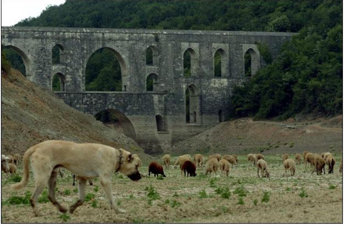
Şekil 2.38. Alibey Barajı'ndaki suyun tükenmiş hali (arsiv.ntvmsnbc.com 2007)
