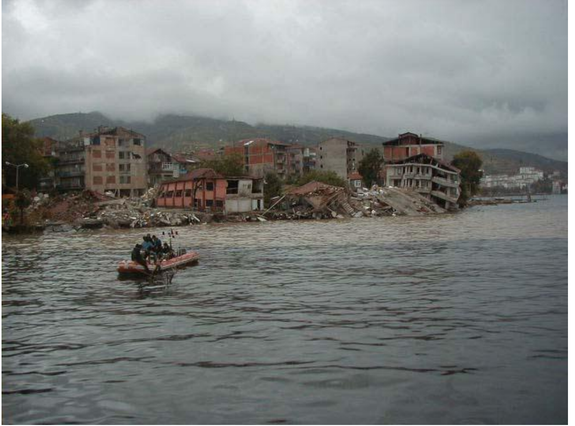
Şekil 2.20. Kocaeli-Değirmendere’de meydana gelen tsunaminin yapmış olduğu hasar
