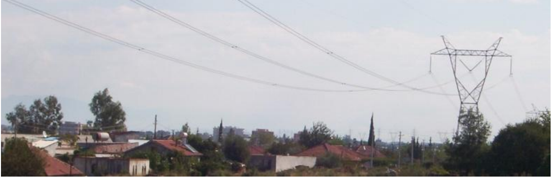
Şekil 4.29. Çalışma yapılan 380kV EİH
