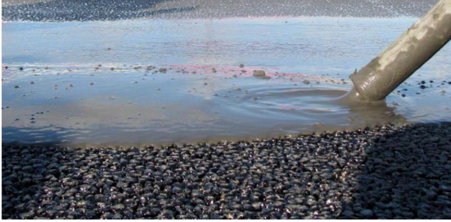
Şekil 1. 1. Yarı Rijit Kaplama Uygulaması (Randy 2007)
