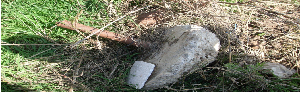
Şekil 3.4. Tahrip edilen gözlem kuyuları
