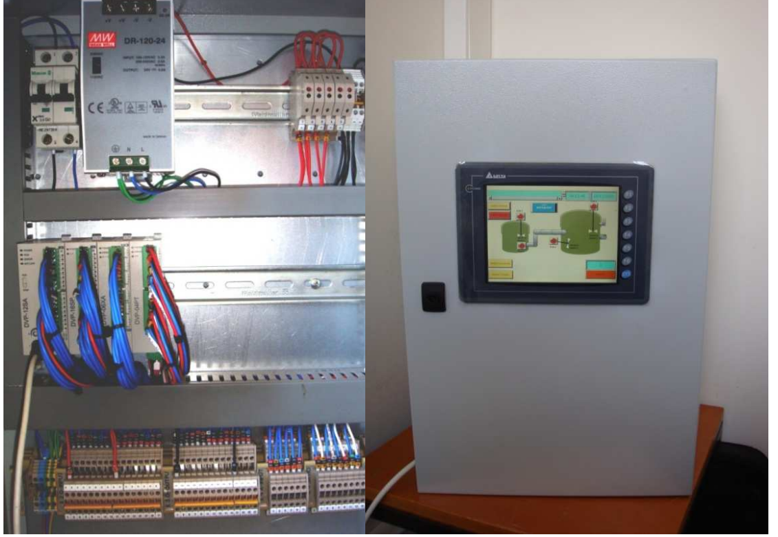
Şekil 3. 3. Biyogaz tesisi otomasyon panosu ve operatör paneli
