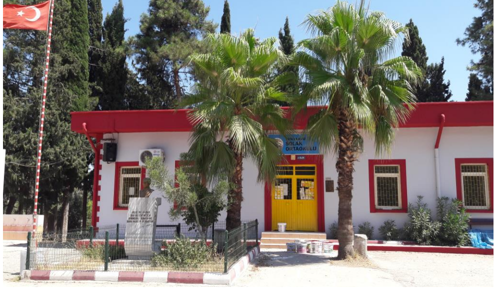
Fotoğraf 4.2.4.4. Okulun Ortaokul Binası
