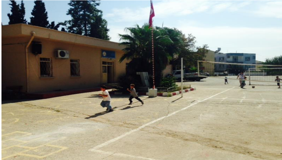
Fotoğraf 4.1.4.5. Okulun Ortaokul Binası
