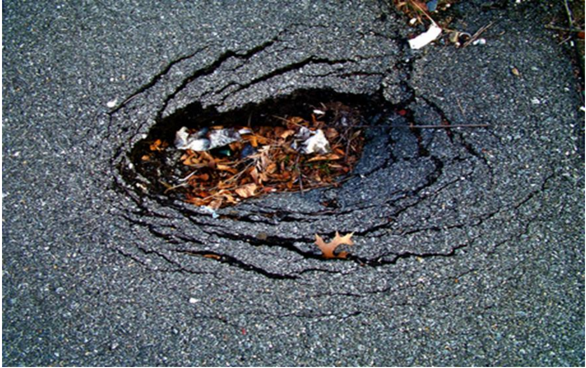
Şekil 2.19. Sökülme ( https://www.movea.com.tr/asfalt-bozulmalari-neden-olusur/ )
