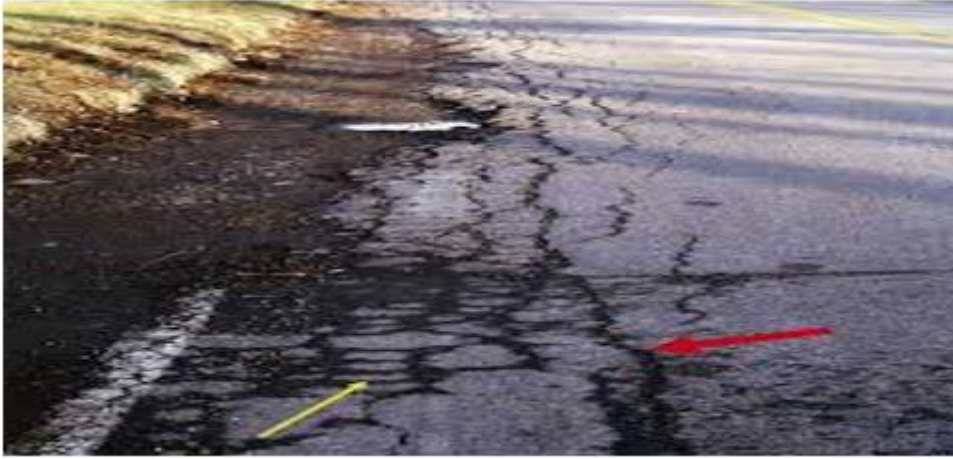
Şekil 2.6. Kenar Çatlağı ( https://insapedia.com/asfalt-yollarda-meydana-gelen-kusur-ve-hasar-cesitleri/ )
