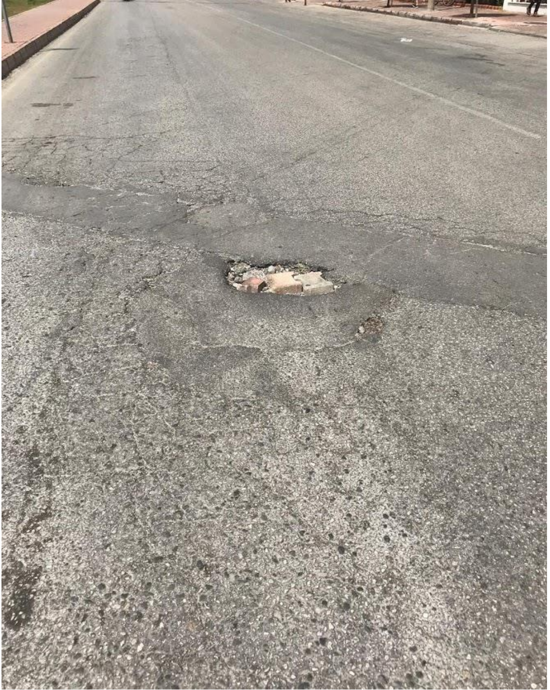
Şekil 4.13. (2) Fener Mahallesi Fener Caddesi
