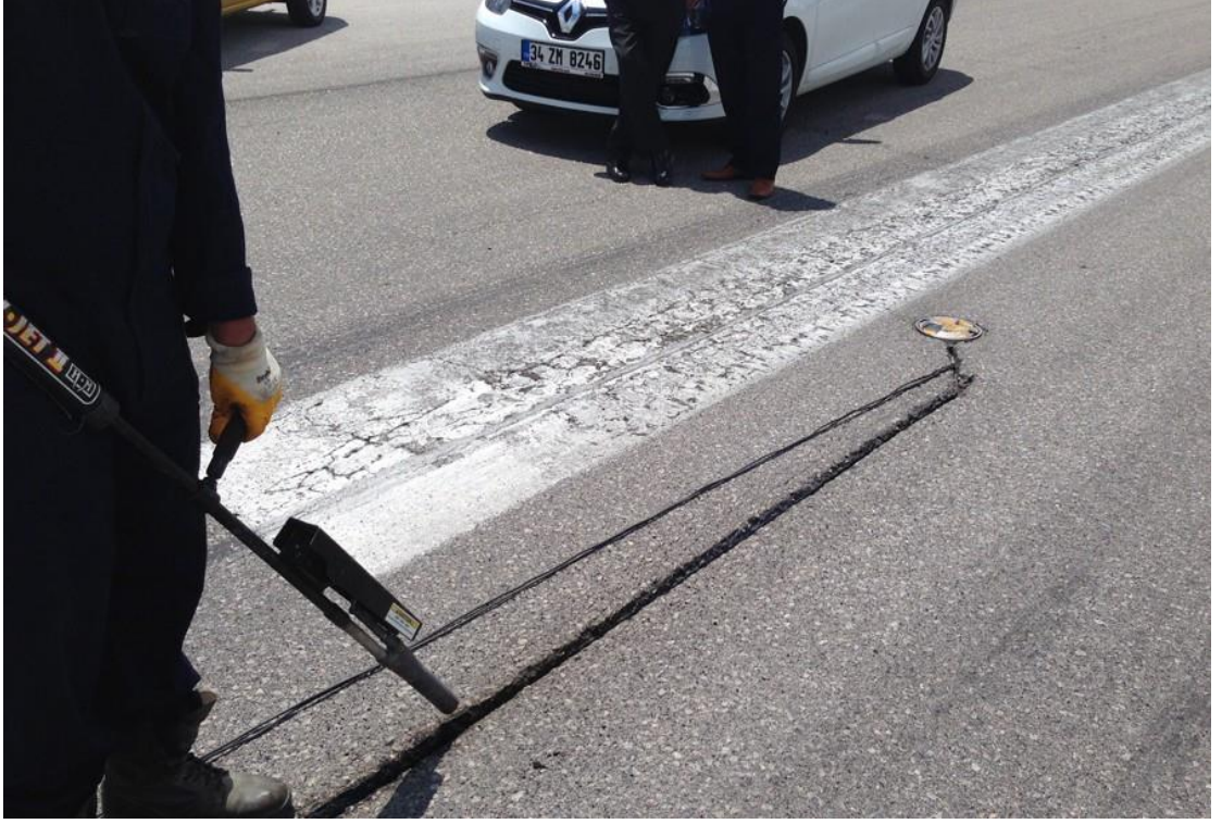
Şekil 2.7. Derz Çatlağı ve Tamiri ( http://www.asfaltkaplama.com/hizmetler/catlak-tamiri-derz-dolgusu )
