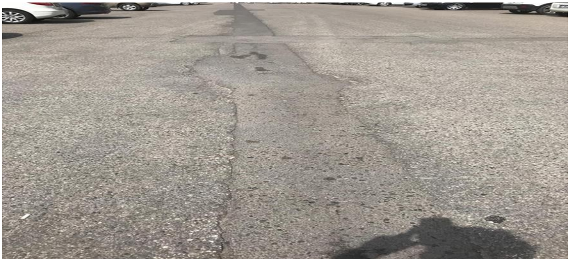
Şekil 4.11. Şirinyalı mahallesi 1548 Sokak
