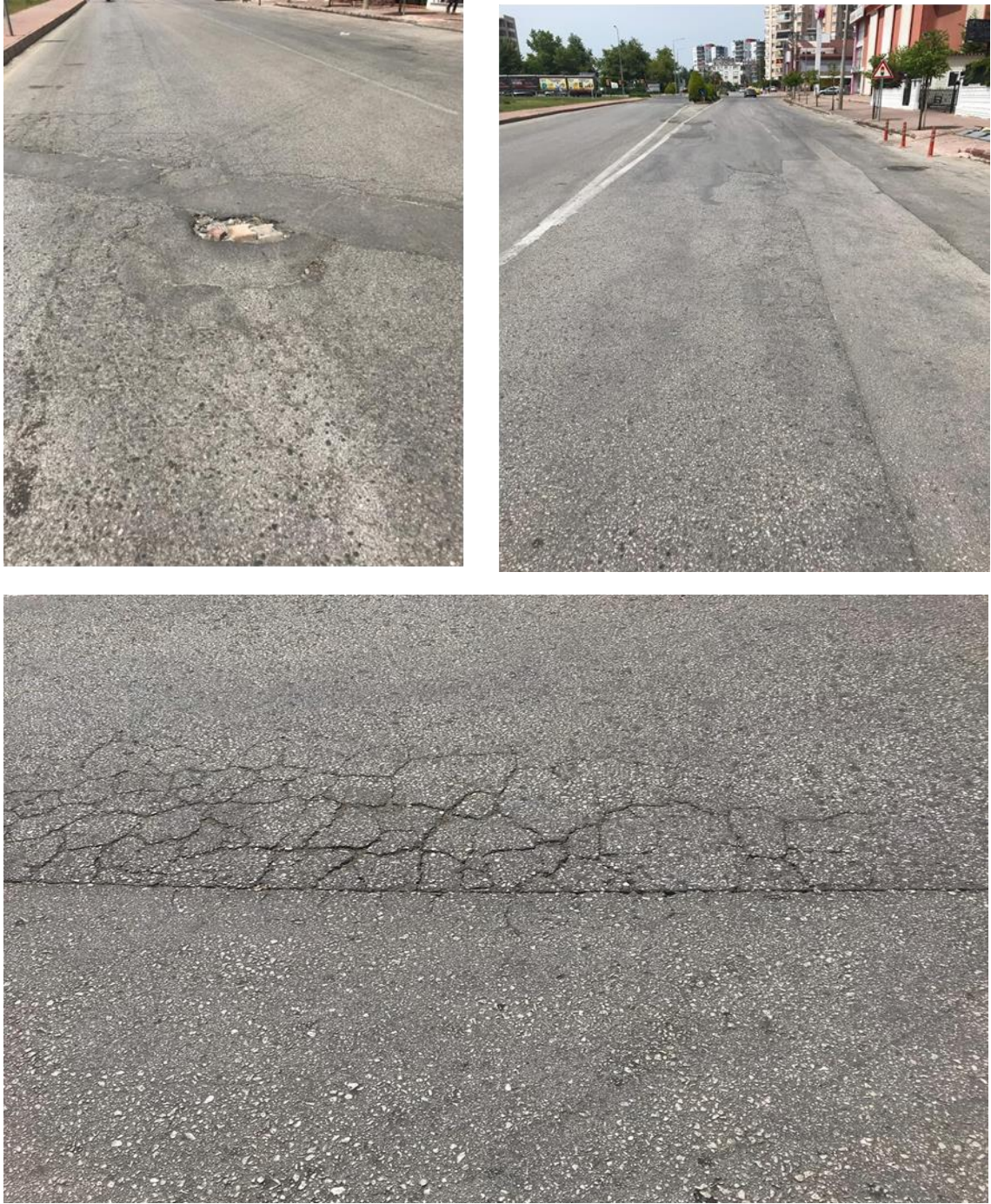
Şekil 4.4. Fener Mahallesi Fener Caddesi
