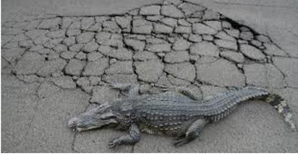
Şekil 2.5. Timsah Sırtı Görünümlü Çatlaklar ( https://insapedia.com/asfalt-yollarda-meydana-gelen-kusur-ve-hasar-cesitleri/ )
