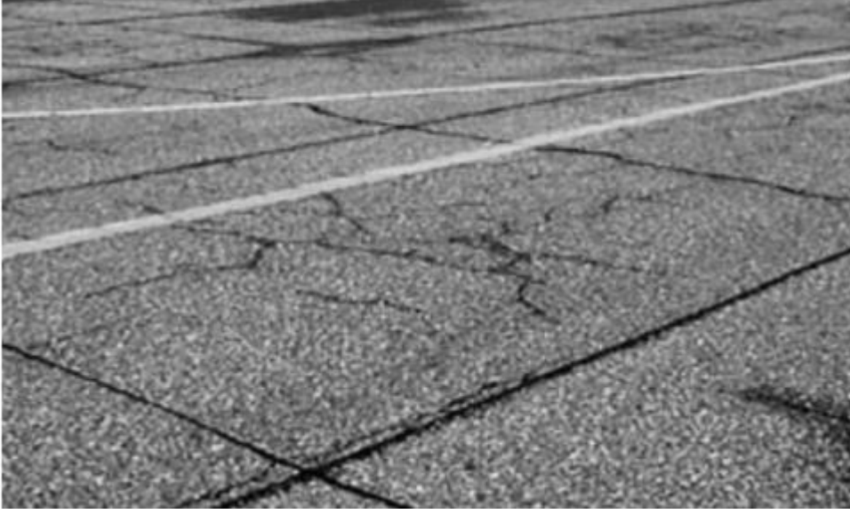
Şekil 2.8. Yansıma Çatlakları ( https://www.movea.com.tr/asfalt-bozulmalari-neden-olusur/ )
