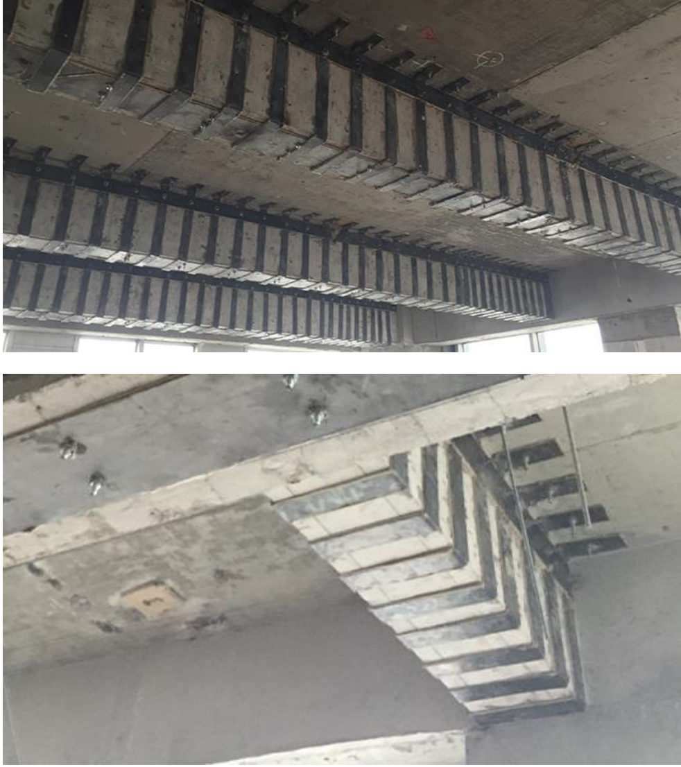
Şekil 3.2. Kirişlerde çelik levhalarla yapılan güçlendirme örneği
