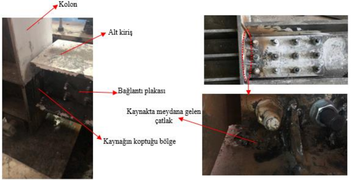
Şekil 4.18. Deney sonrası çerçeve sistemde meydana gelen hasarlar
