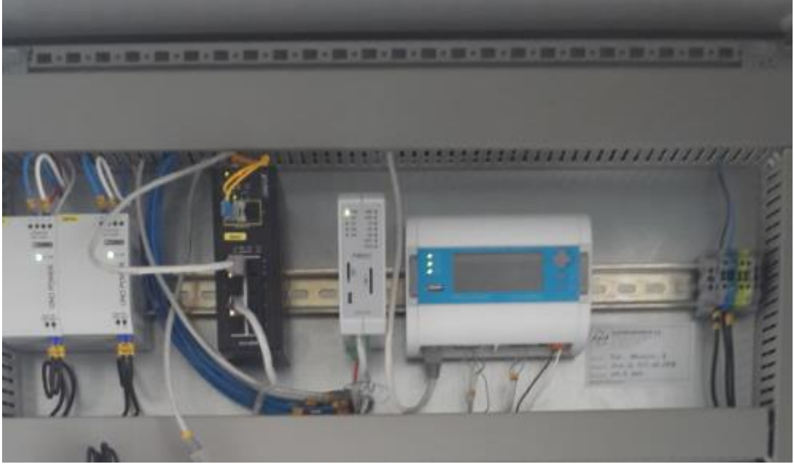
Şekil 3.19. GES İnverter Kontrolü İçin Montajı Yapılan Datalogger Test Düzenegi
