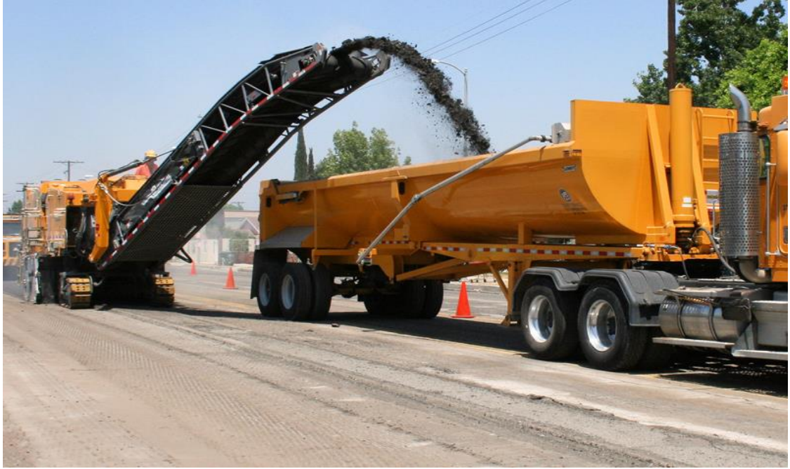
Şekil 2.8. Soğuk Düzeltme İşlemi ve Yol Yüzeyi (www.middleeast.com 2018)
