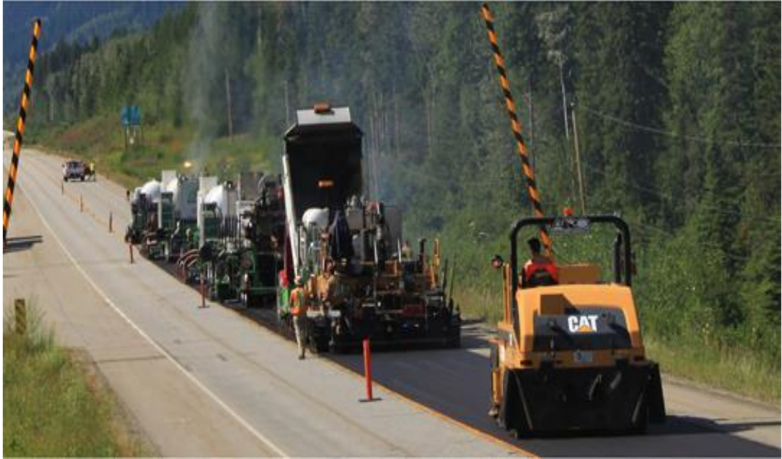
Şekil 2.9. Sıcak Yerinde Geri Dönüşüm (www.ecopavesystems.com 2018)
