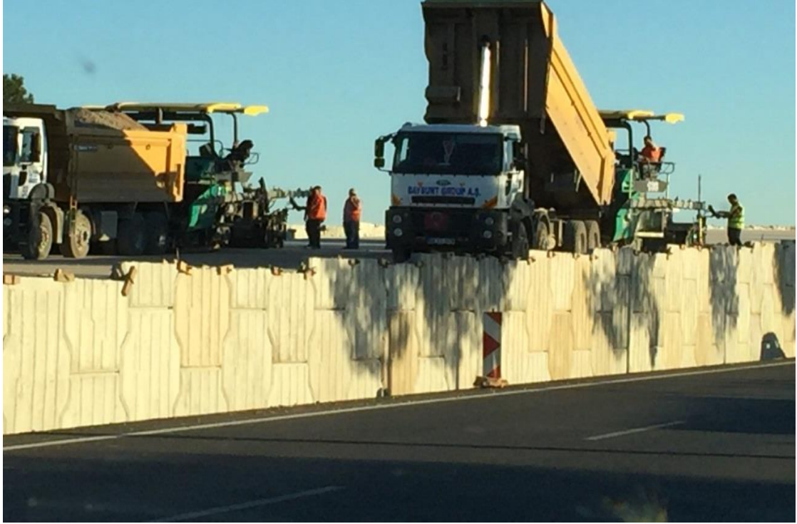
Şekil 2.7. Bitümlü Sıcak Karışımın Yola Finişerle Serilmesi İşlemi
