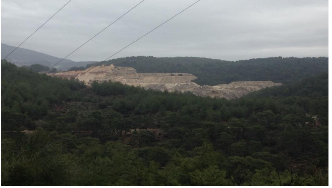
Şekil 3.3. Çalışma alanında aktif olarak çalışan açık işletme ocağının görünümü
