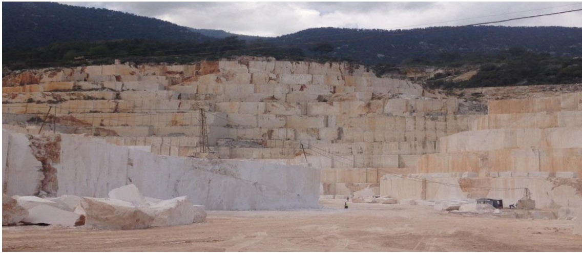
Şekil 4.8. Mermer açık işletmelerinde herhangi bir önlem alınmamış yüksek kademelerin görünümü
