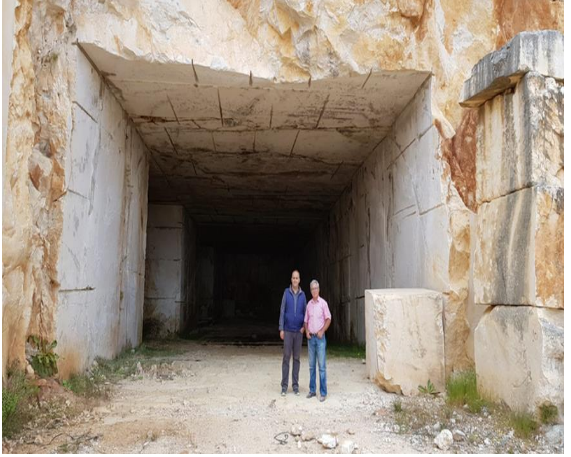
Şekil 1.8. Yeraltı işletmeciliğine ait görünüm
