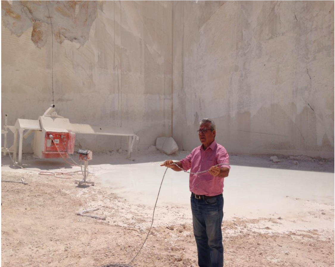
Şekil 4.6. Tel kesme makinasının ve elmas tel kablosunun açık ocak içindeki görünümü
