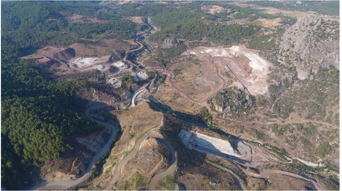
Şekil 4.8. Küçük Aksu Barajı (Anonim 2019)
