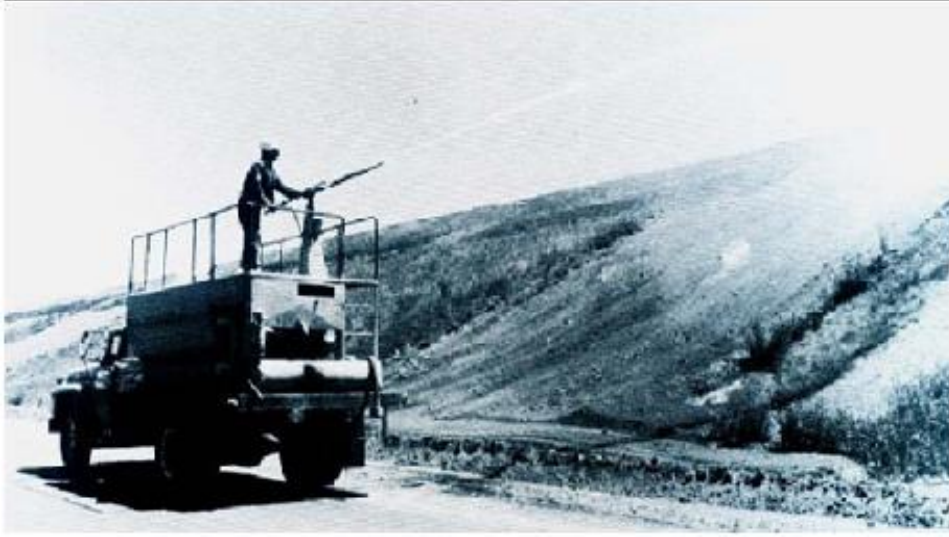
Şekil 3.1. Hidrotohumlamannın uygulanma örneği (Pamukçu 2004)
