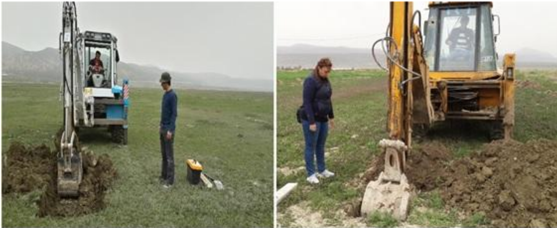
Şekil 3.5. Profil çukurlarının iş makinesi ile açılması
