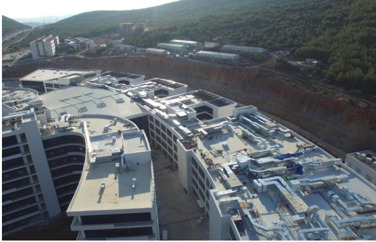
Şekil 4.7. Muğla Sıtkı Koçman Üniversitesi Eğitim ve Araştırma Hastanesi kuzeydoğu cephesinde yer alan klinik girişlerinin bulunduğu yol aksı (EMT 2018)
