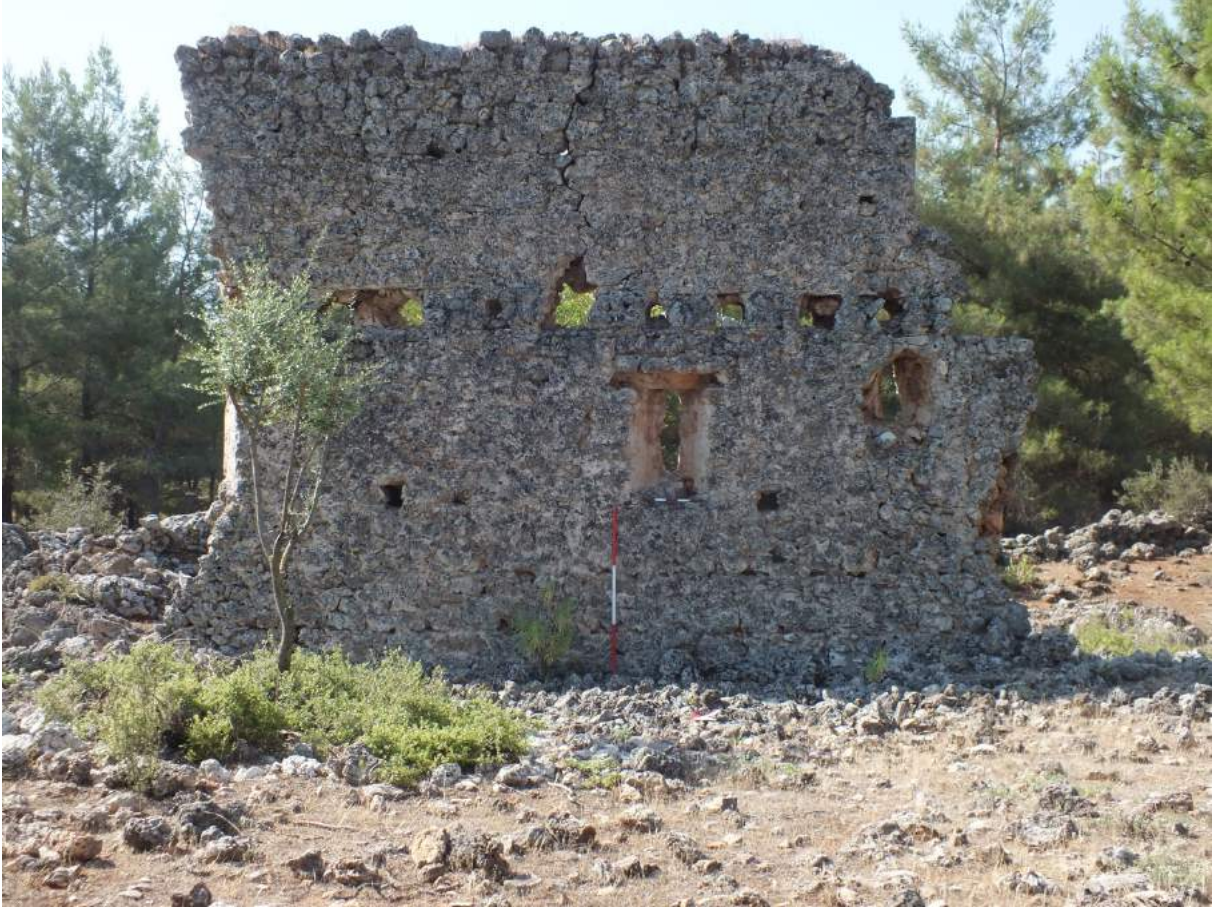
Görsel 146. 113 numaralı yapı, güneydoğu köşedeki mekân, güney duvarı.
