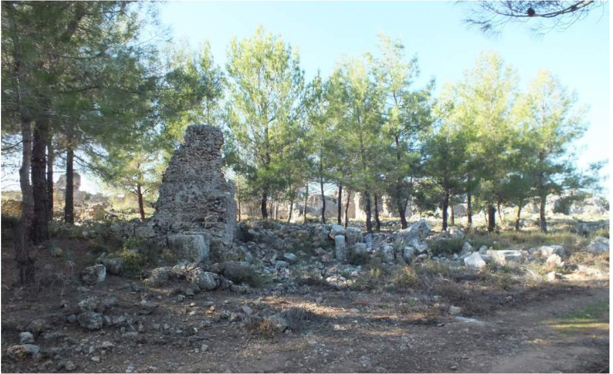
Görsel 101. Solda 73 ve sağda 74 numaralı yapının bulunduğu alan.
