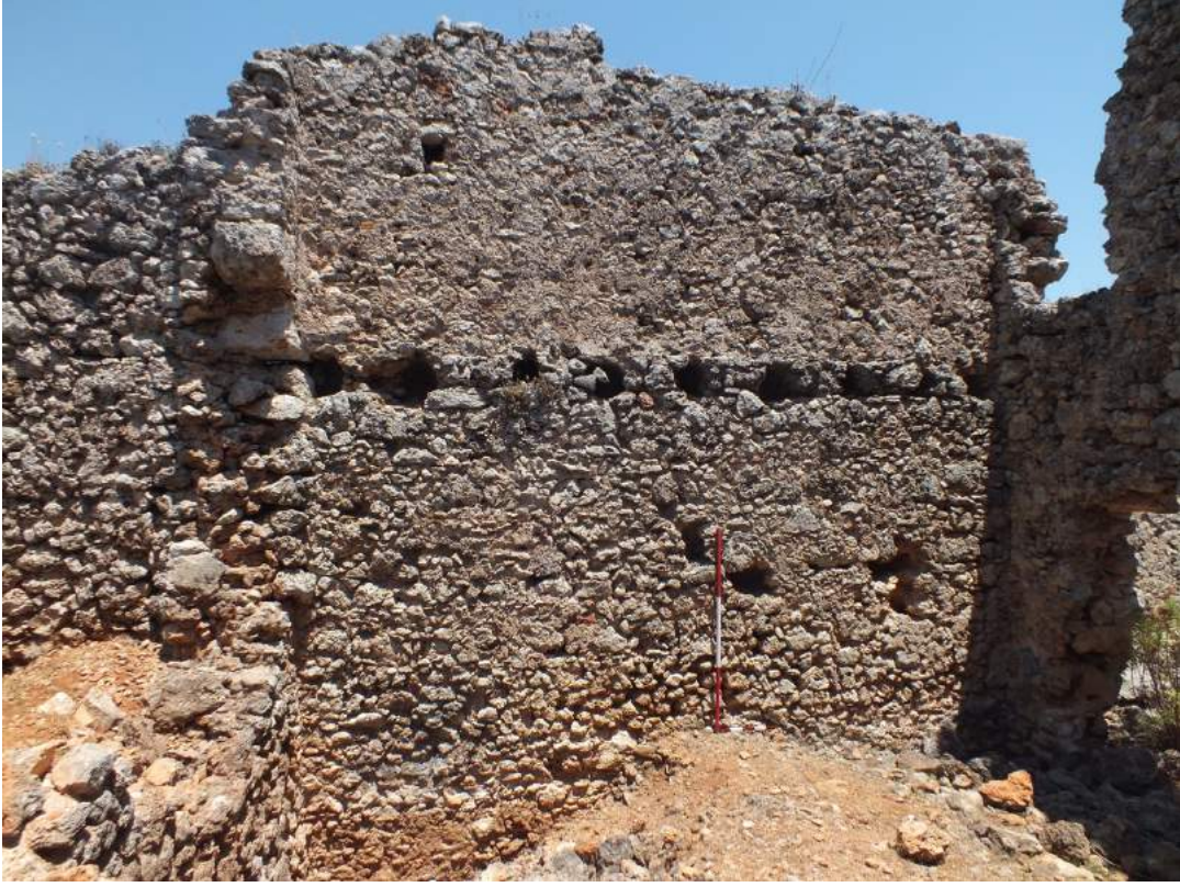
Görsel 174. 16 numaralı konut, üst kat döşemesini taşıyan kiriş yuvaları.
