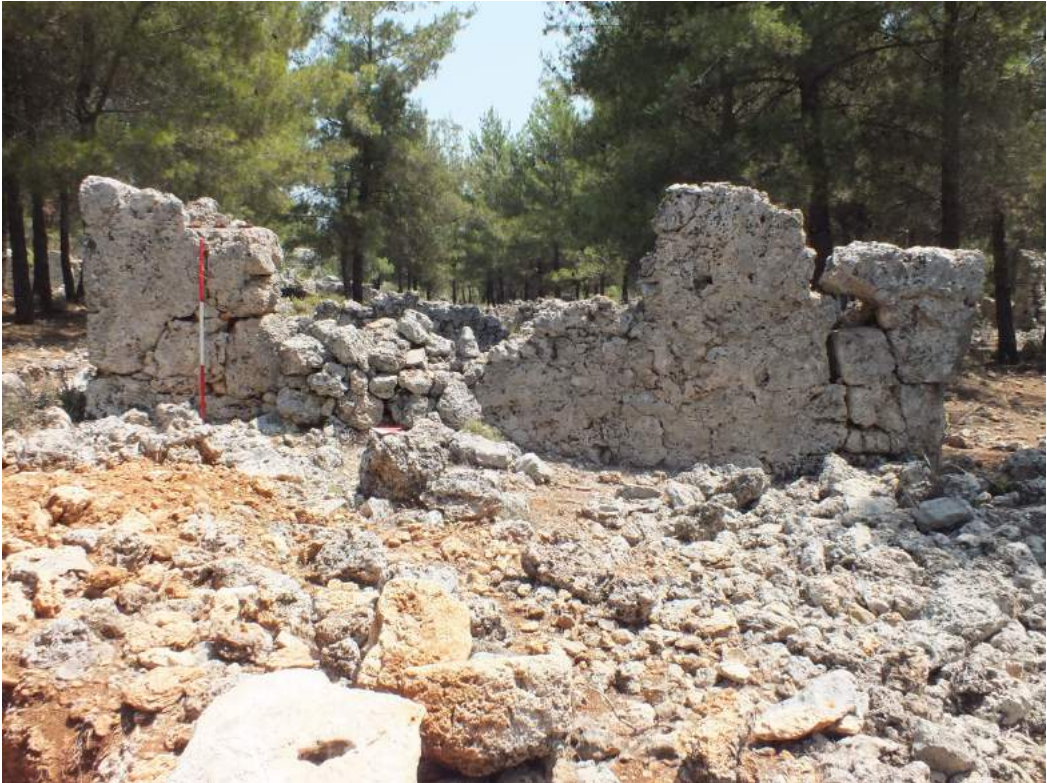
Görsel 122. 91 numara, güneybatı cephe.
