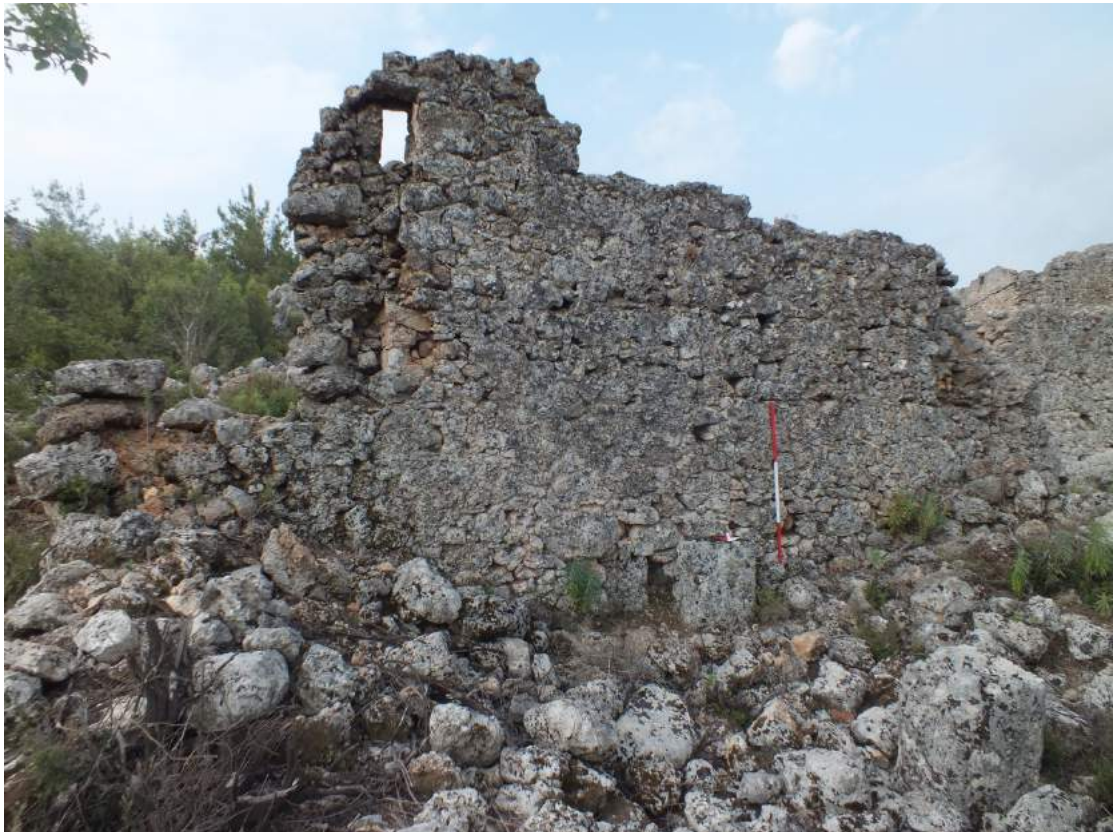
Görsel 177. 68 numara, olasılıkla üst kat döşemesini taşıyan kemerlere ait ayaklar.
