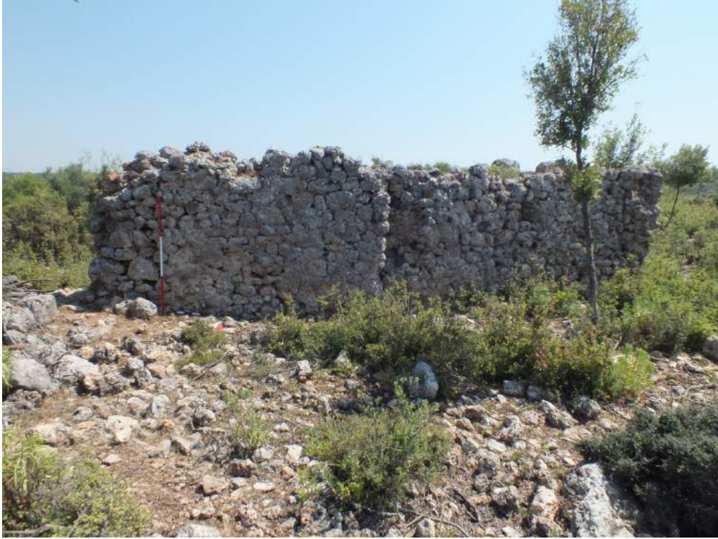
Görsel 13. 2 numara, güneybatı cephe.
