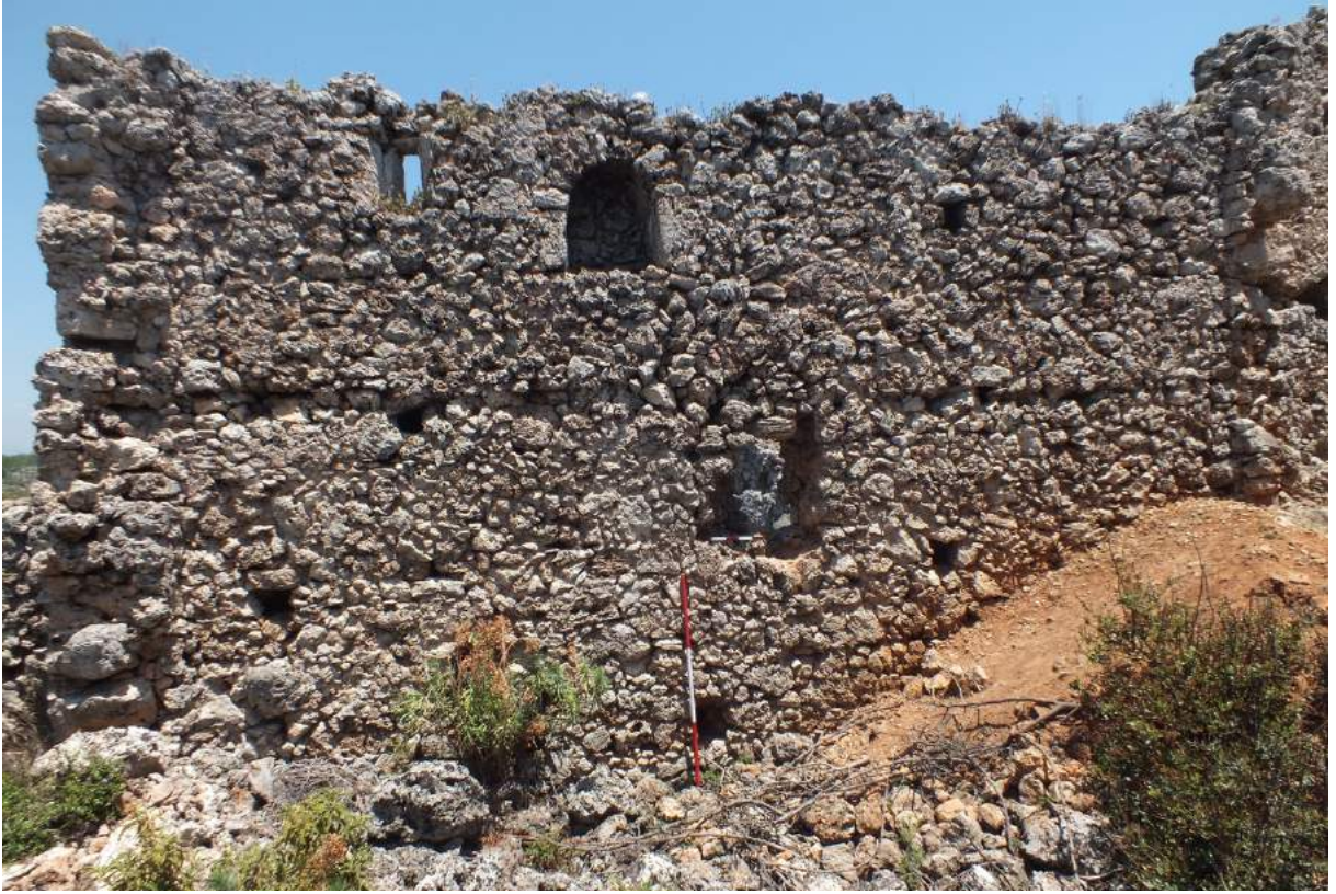
Görsel 176. Üst kat döşemesinin yerleştirildiği girinti.
