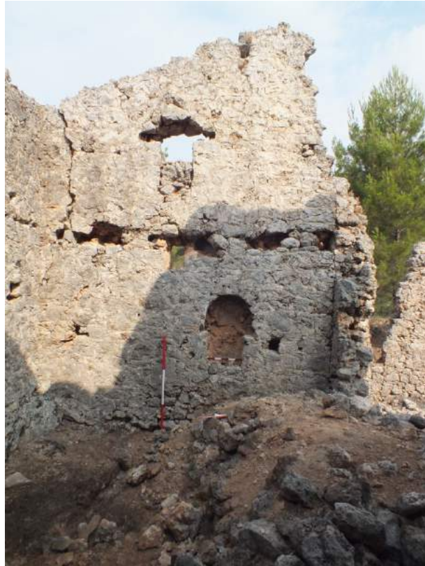
Görsel 181. 66 numaralı yapıya (Güney Kilise) bitişik erken konut, tek eğimli çatı örneği.
