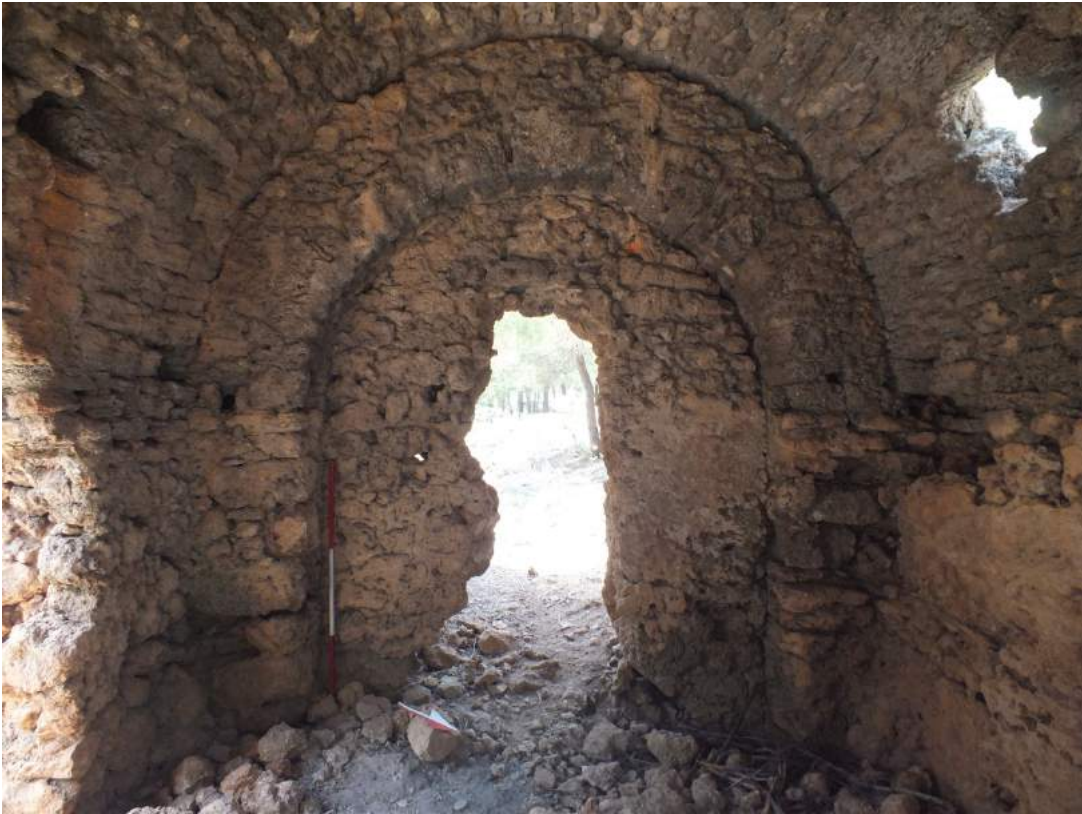
Görsel 114. 84 numaralı yapı (Hamam), a mekânı, güneybatı kemerli açıklık.
