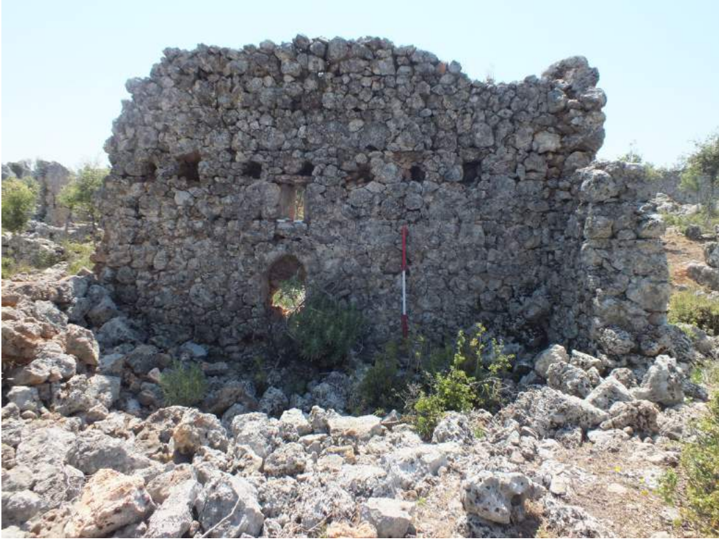
Görsel 21. 8 numara, konut a mekânı, güneydoğu iç duvar.
