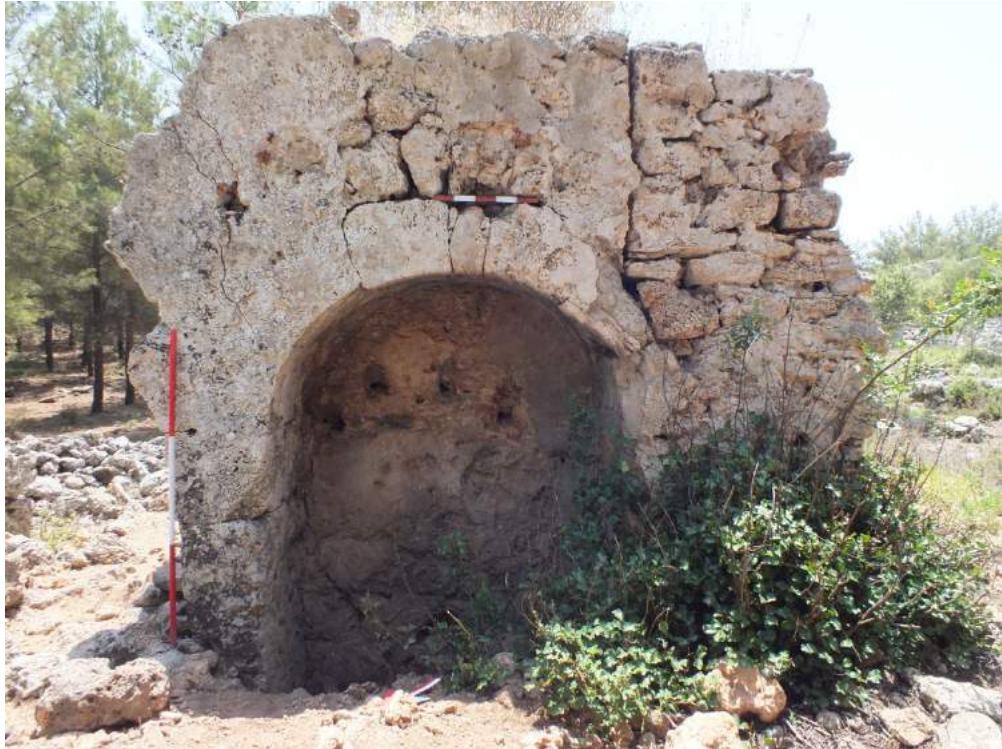
Görsel 116. 84 numaralı yapı (Hamam), b mekânı, kemerli niş.
