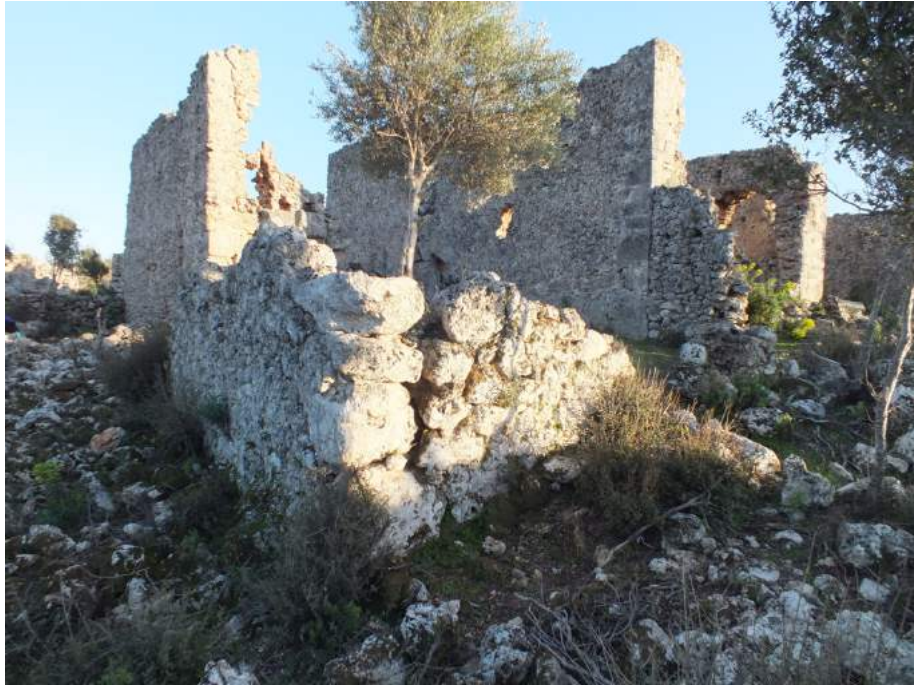
Görsel 37. 16 numaralı konut, h mekânı (avlu) kuzeybatı duvarı.
