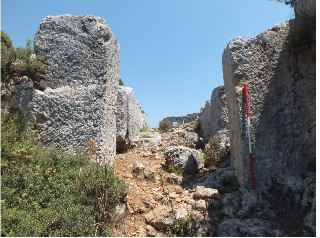
Görsel 229. 20 numaralı giriş açıklığı, güney cephe.
