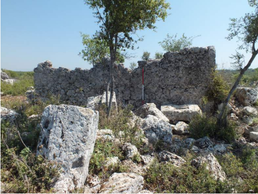
Görsel 23. 9 numara, güneybatı cephe.
