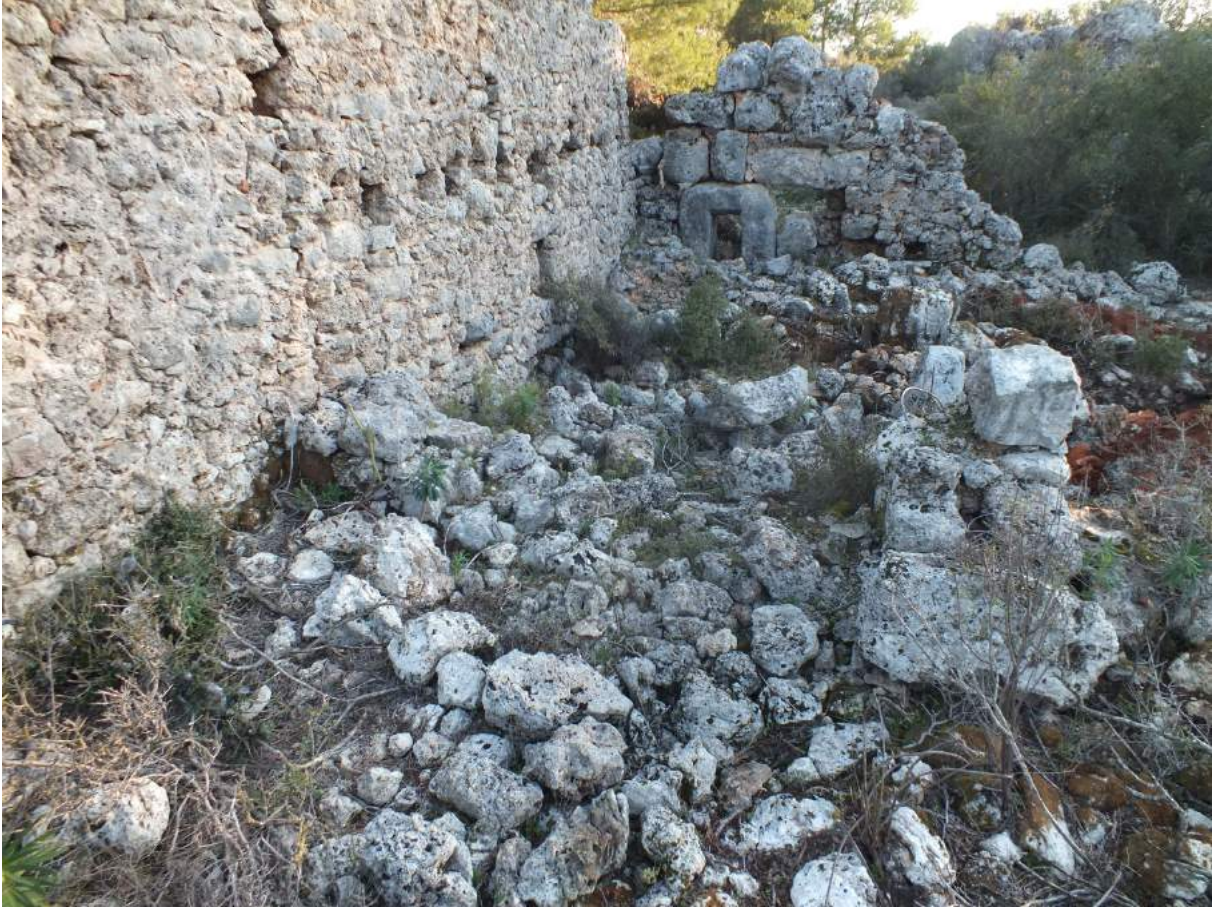
Görsel 148. 114 numara, işliğin bulunduğu kuzey bölümü.
