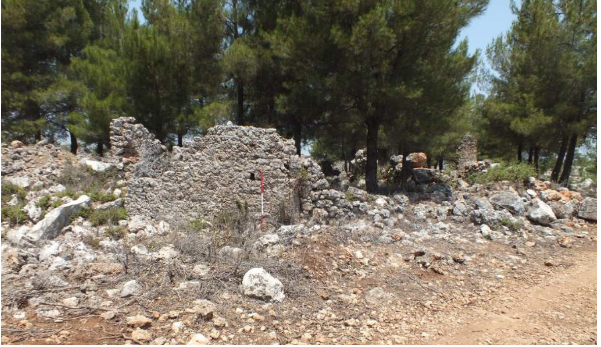
Görsel 98. 72 numaralı yapı, güney cephe.
