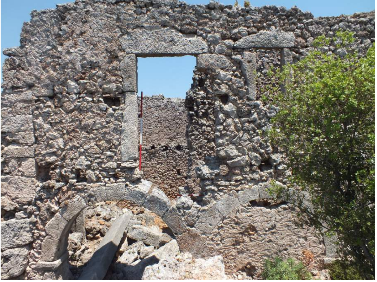
Görsel 172. 16 numaralı konut, kemerler üstünde balkonun döşemesini taşıyan kirişlere ait yuvalar.
