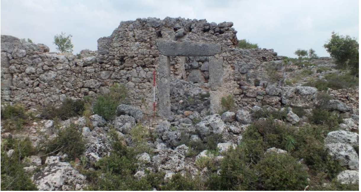
Görsel 170. 55 numaralı yapı, zeytinyağı işliğı mekanına açılan kapının cephesinde ahşap sundurmaya ait olabilecek giriş yuvaları.
