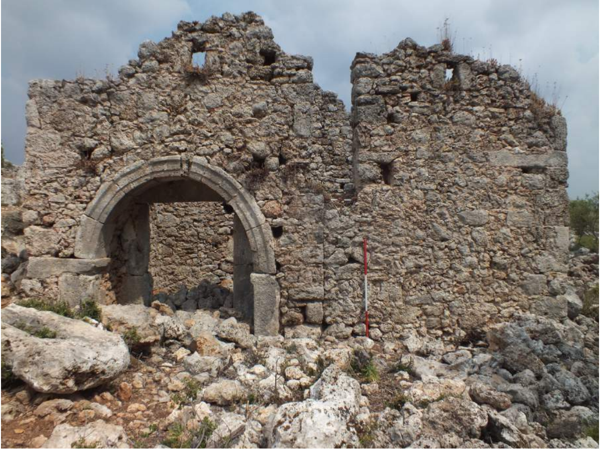
Görsel 71. 54 numara, güneydoğu cephe.
