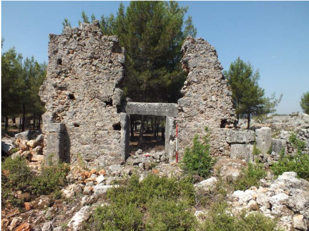
Görsel 128. 95 numara (Kuzey Kilise), naos güneybatı iç duvarı.
