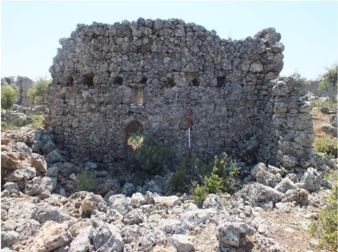
Görsel 175. 8 numaralı konut, üst kat döşemesini taşıyan kiriş yuvaları.
