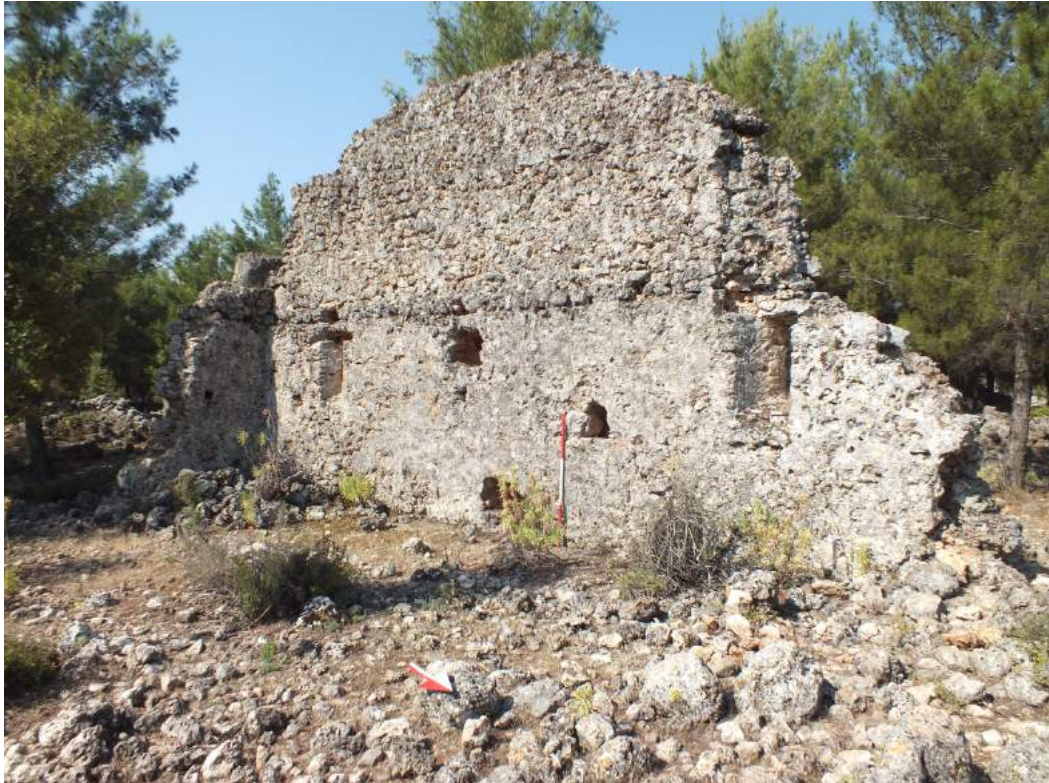
Görsel 147. 113 numaralı yapı, mekânın içine bakan güneydoğu duvarı.
