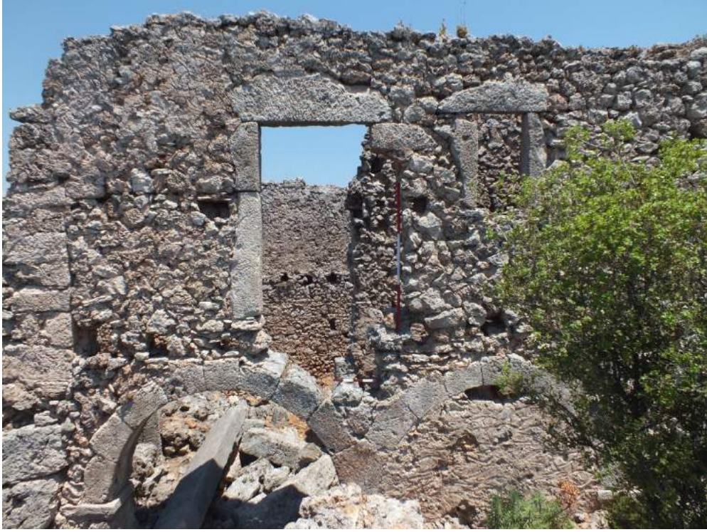
Görsel 168. 16 numaralı konut, balkona açılan kapı ve büyük boyutlu pencere örneği.
