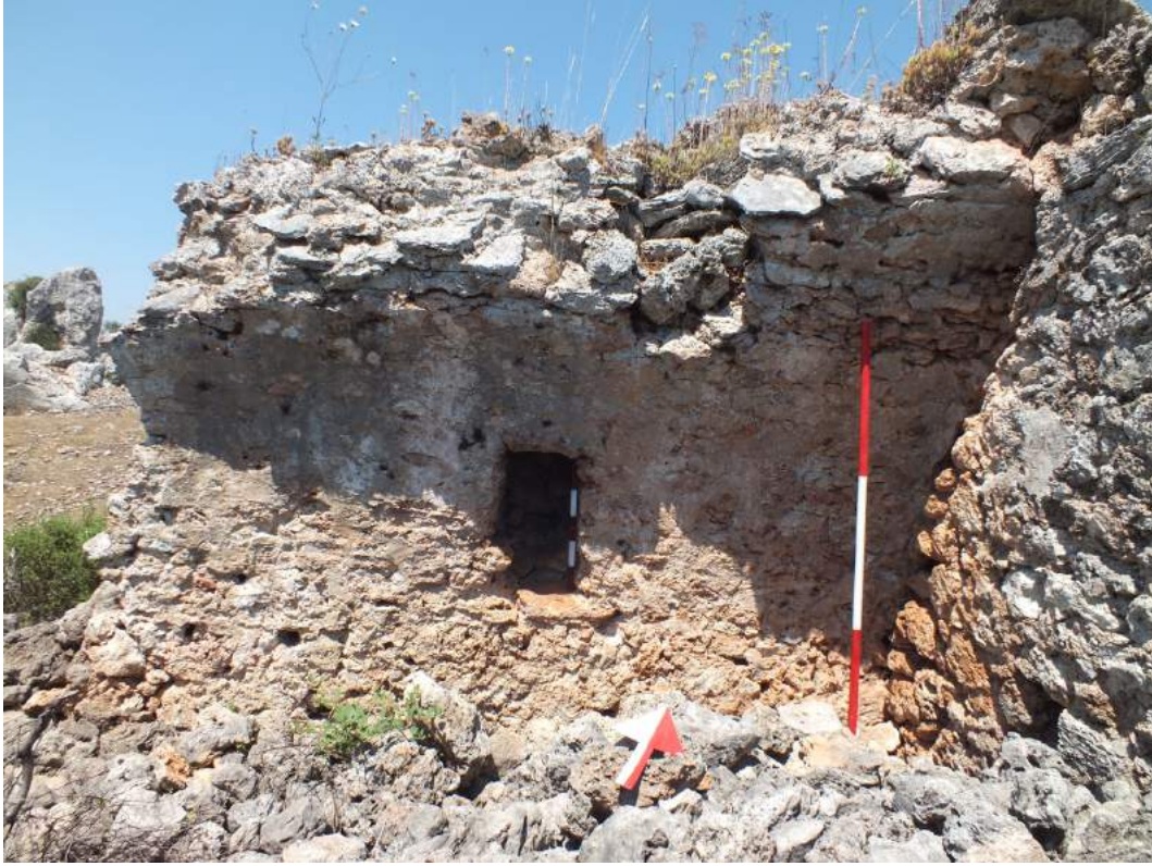
Görsel 50. 27 numara, tonozlu bölüm iç mekân, kuzey.
