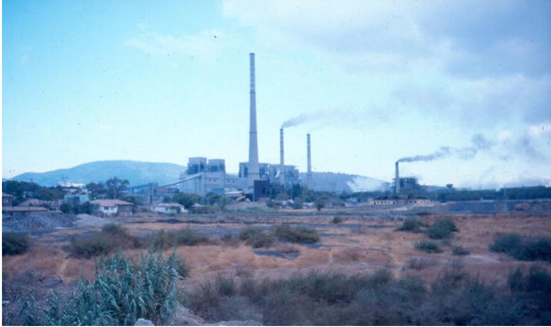
Şekil 2.1. Soma termik santralinden genel bir görünüm.
