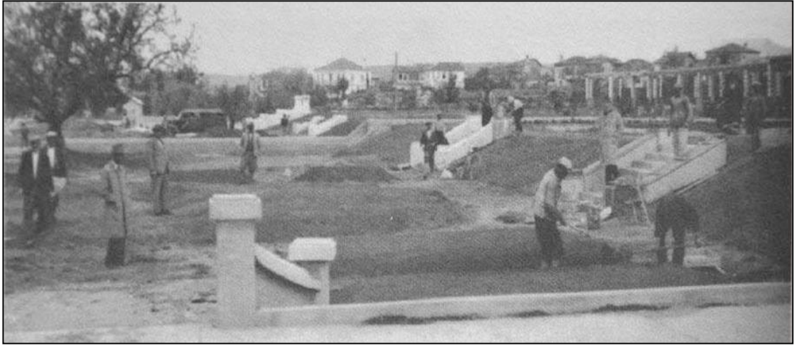
Şekil 3.5. Karaaliođlu parkı inşaatından bir görüntü (imrin 2006)
