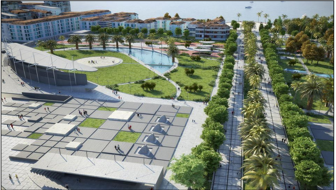
Şekil 4.5. Eski otopark alanında yapılan meydan ve katlı otopark düzenlemesi (Anonim 24)
